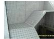
سازه در حال اجرای دیوار سه بعدی (3D panel)
