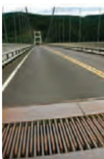
(ب) نمونه‌ای از بست‌های انبساطی
