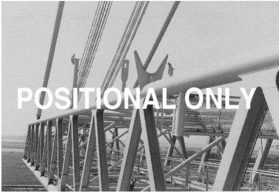
Fig. 7.4.10 Lattice girder
