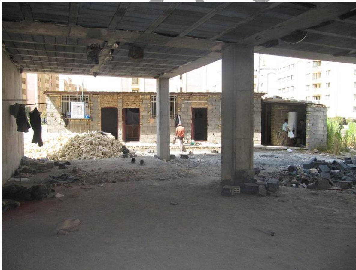
شکل ۱۲- محل استقرار کارگران در کارگاه
