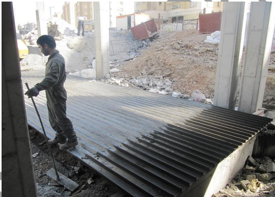
شکل ۷- کارگاه ساخت تیرچه در محوطه ی پروژه
