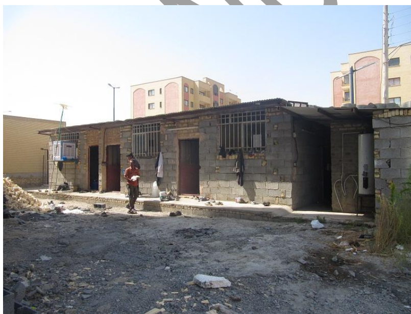
شکل ۶- ساختمان استراحت کارگران
