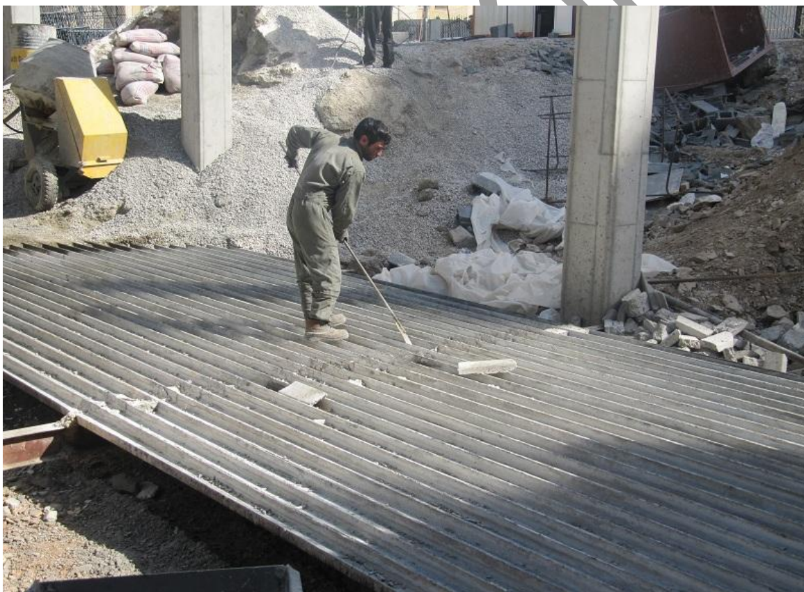
شکل ۱۷- کارگر مشغول گازوییل زنی قالب
