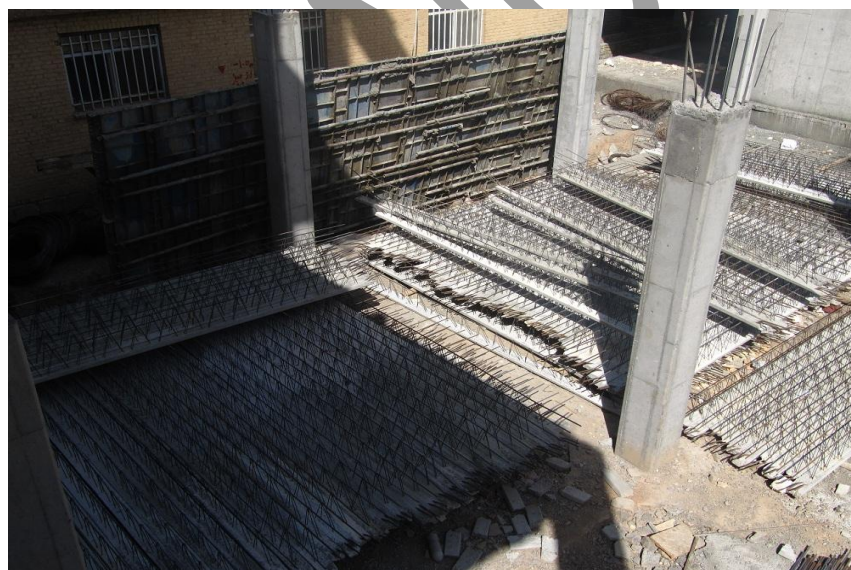
شکل ۹- کارگاه ساخت تیرچه
