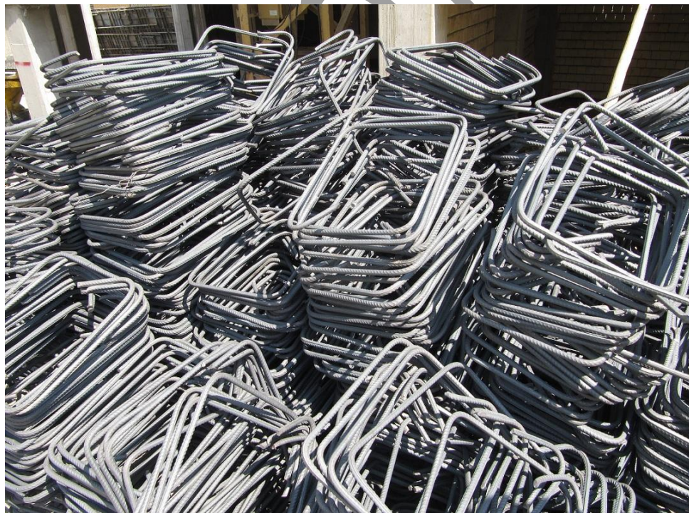
شکل ۱۵- خاموت های استفاده شده در پروژه
