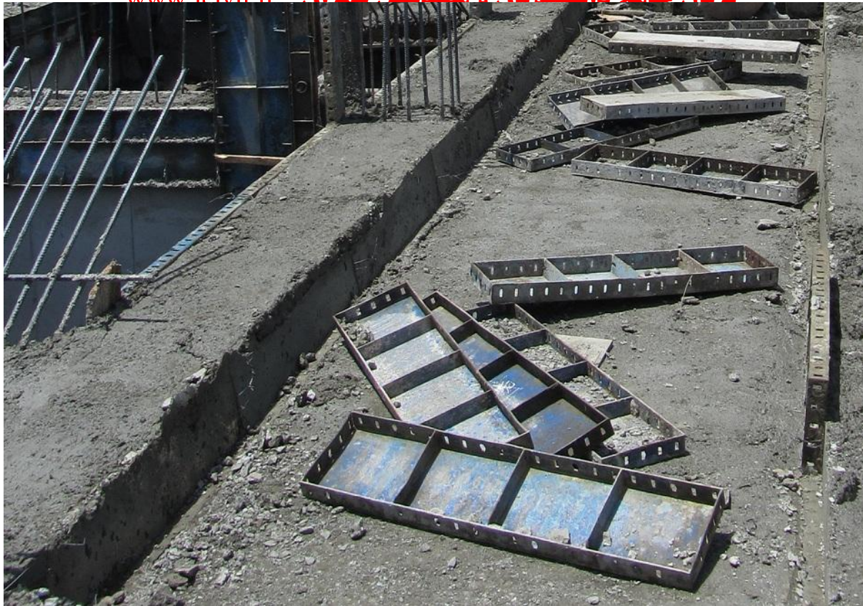
شکل ۱۳- قالب های استفاده شده در پروژه
