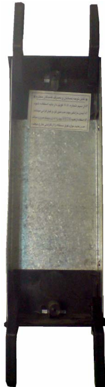
نصب گیره های تراز روی قوطی توکار
