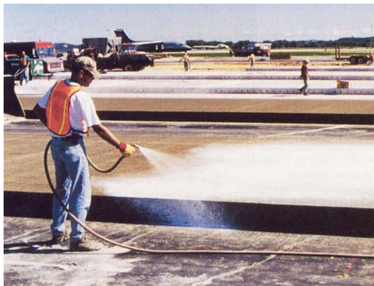
شکل ۴ روش عمل‌آوری با ماده شیمیایی غشایی
