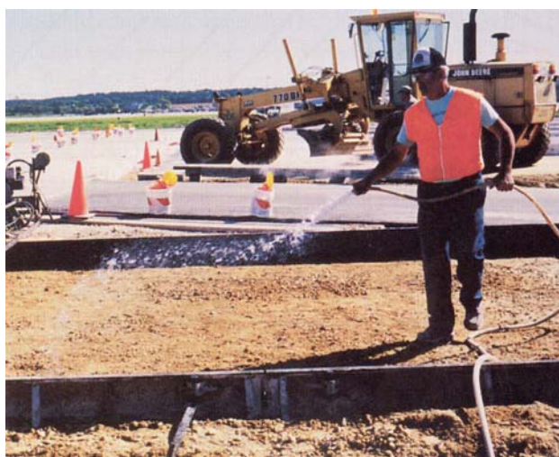
شکل ۲ آب‌پاشی روی سطح زمین، قبل از بتن ریزی در هوای گرم، برای کاهش دما
