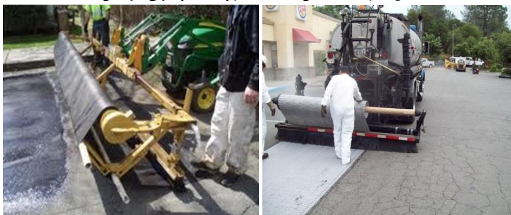
شکل شماره ۲۱: ماشین نصب لایه‌ی ژئوسنتتیک و معرفی اجزای آن
