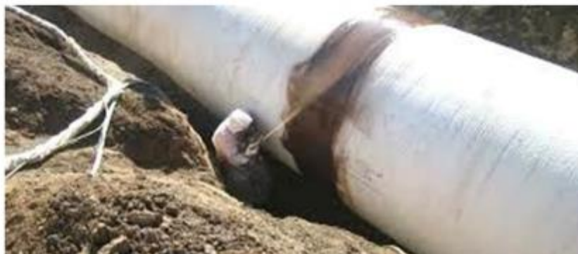
شکل ۲۰.۴. تصویر اعمال پوشش در محل اتصال لوله‌ها به یکدیگر [۳۶]
