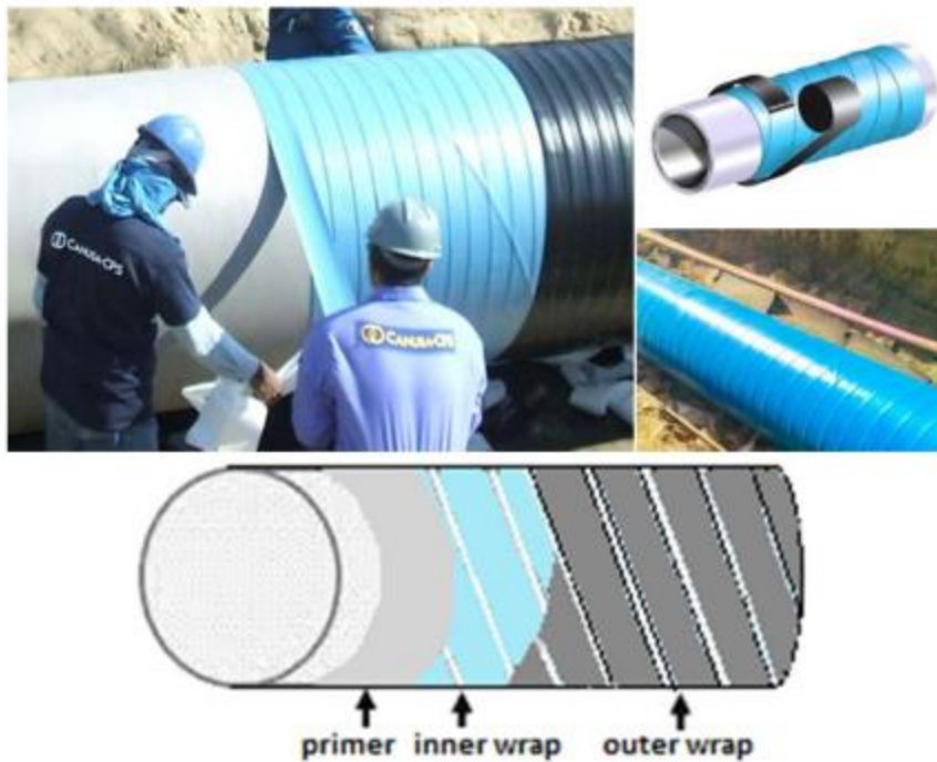
شکل ۲۴.۴. تصویر پوشش نواری سه لایه برای اصلاح مناطق معیوب پوشش خطوط لوله [۴۲]
