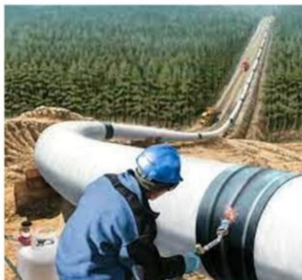
شکل ۱۹.۴. تصویر اعمال پوشش در محل اتصال لوله‌ها به یکدیگر [۳۵]
