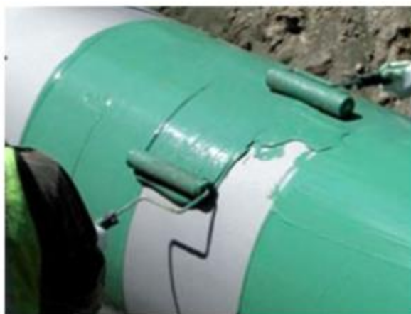
شکل ۲۵.۴. پوشش مایع اپوکسی برای ترمیم پوشش معیوب [۱۲]
