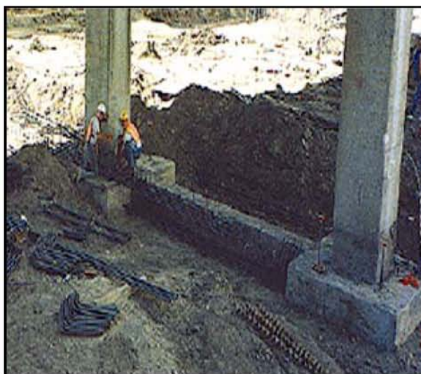
شکل ۴-۲-۲ - به هم بستن شالوده‌ها با شناژ
