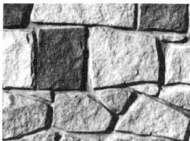
شکل : دیوار با سنگ چندوجهی سرتراش رجدار
