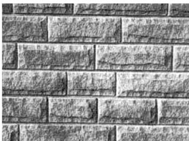
شکل : دیوار با سنگ بادیتر مرتب و با رج‌های مساوی
