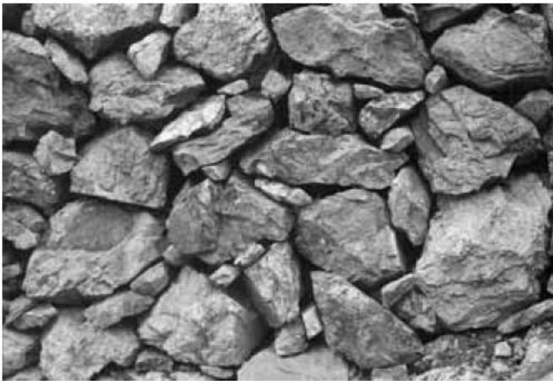
شکل : نمای دیوار لاشه‌چینی شده بدون ملات
