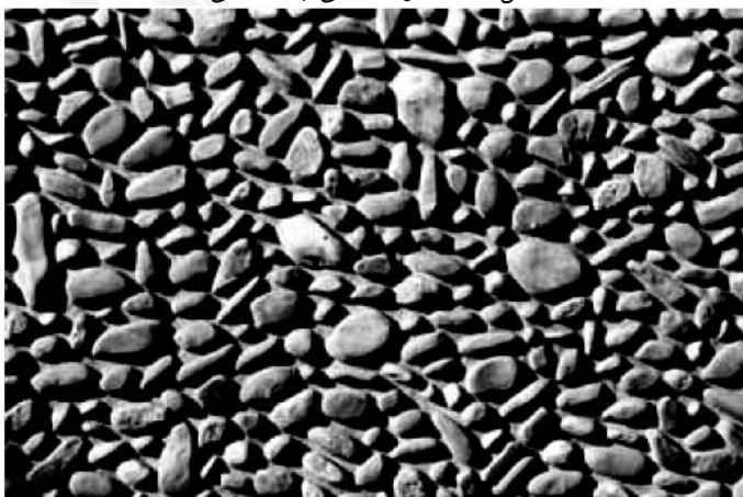
شکل : نماسازی با سنگ قلوهای رودخانه‌ای
