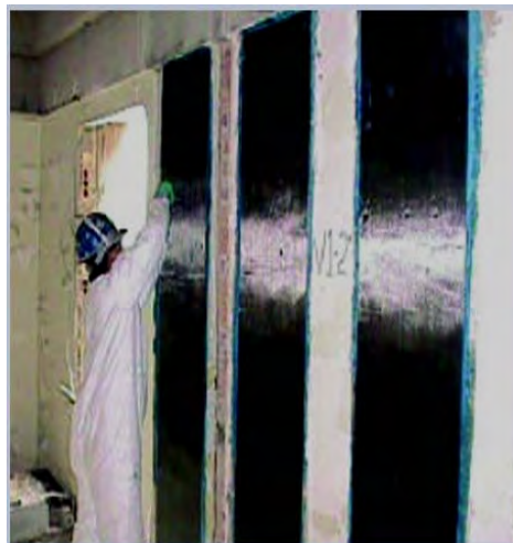
شکل ۸-۱۹ - نحوه اجرا و نصب نوارهای FRP
