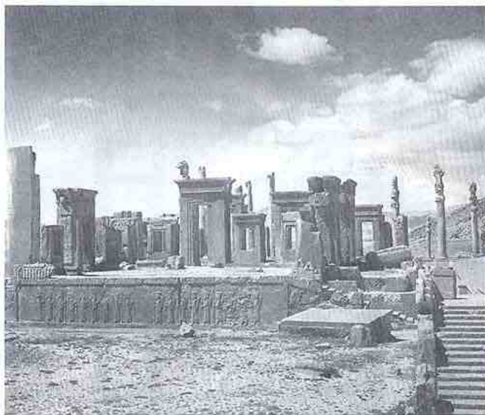
تصویر 87 - چشم انداز جنوبی کاخ داریوش - قسمت جلو سکوی بلکان ورودی
