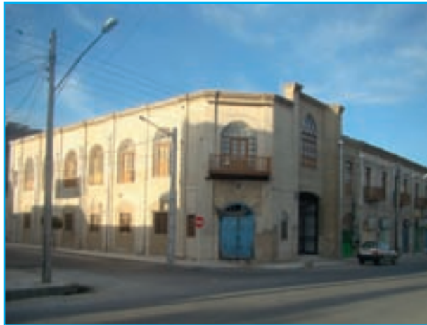
شکل ۷-۱۲- ساختمان دادگستری قدیم
