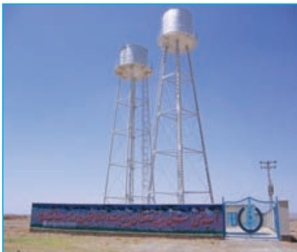
شکل ۱۰-۱۴- اجرای طرح آبرسانی بهداشتی روستایی
