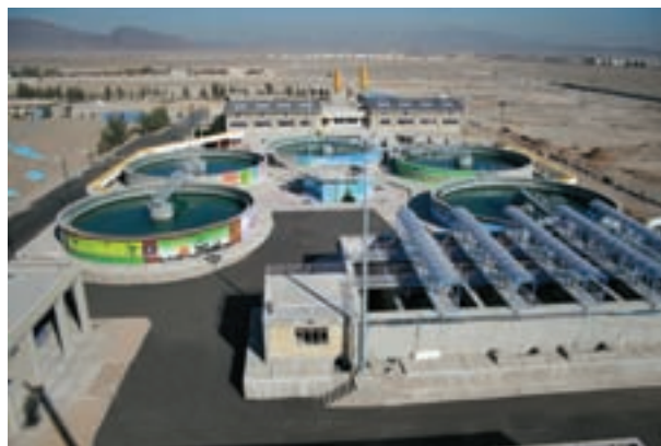
شکل ۱۲-۴ تصفیه خانه آب زاهدان
