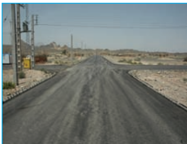
شکل ۹-۱۴- اجرای طرح‌های روستای چگرد خاش
