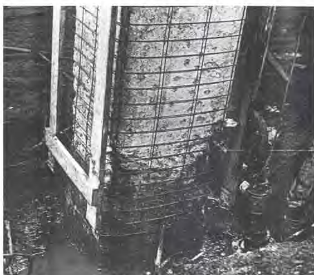
ب- اجرای روکش بتنی با بتن پاشی
