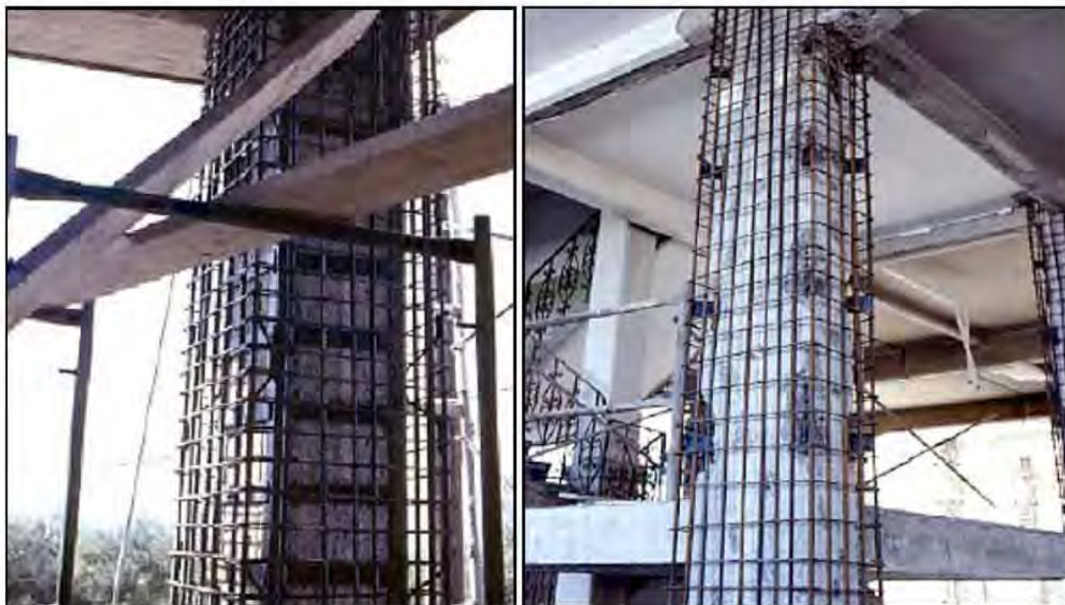
شکل ۲-۵-۹- استفاده از روکش بتنی جهت بهسازی ستون‌ها
