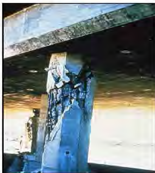
شکل ۲-۵-۱- نمونه‌ای از شکست برتشی ستون
