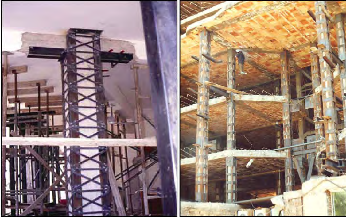
شکل ۲-۵-۱۳- بهسازی ستونهای بتنی بوسیله روکش فولادی قفسه‌ای
