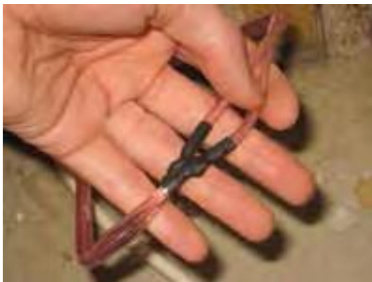
شکل ۶۳-۱ اتصال سه تایی با روکش وارنیش حرارتی
