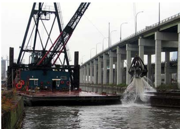
کلامشل در حال عملیات لایروبی
