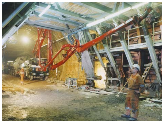
پمپ بتن تونل
