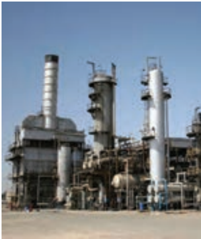
ب) نمای بیرونی برج تقطیر در پالایشگاه
