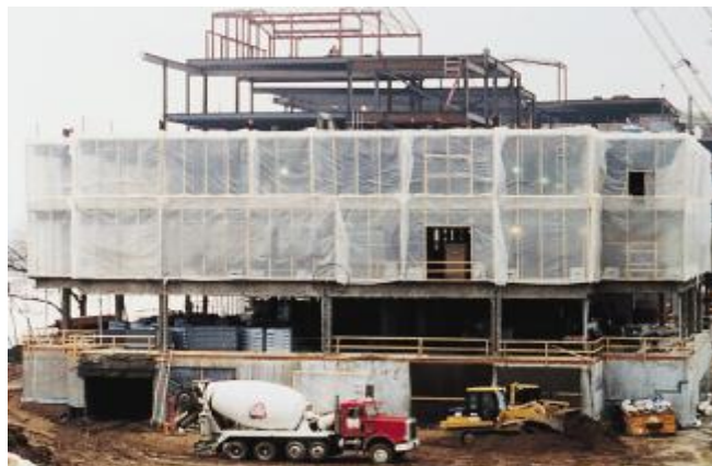
شکل ۲ برای محصور کردن اسکلت ساختمان از ورقهای پلاستیکی پلی اتیلن استفاده شده است.
