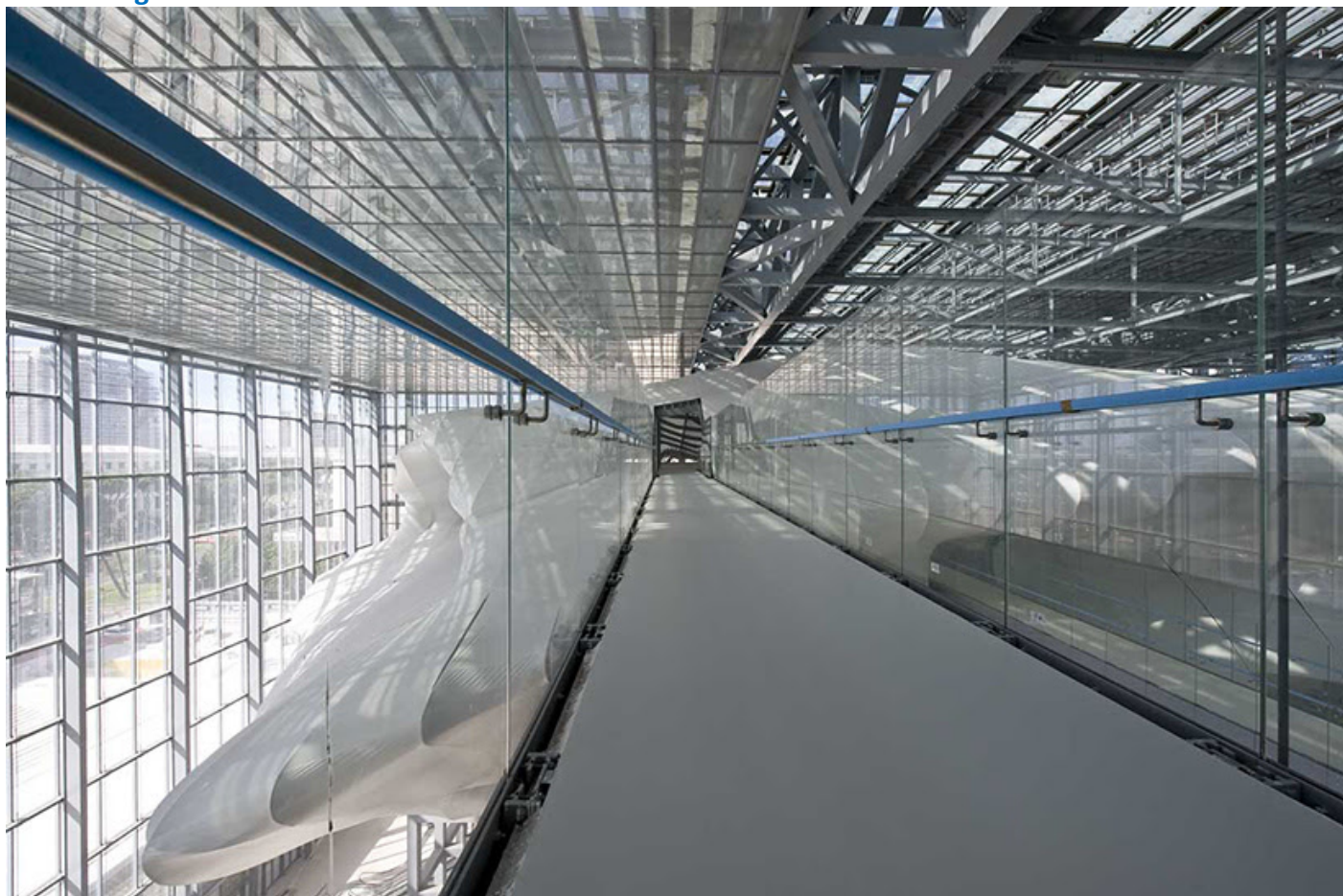
سازه فولادی مجموعه با استفاده از یک پرده شیشه ای شفاف پوشانیده شده است .
