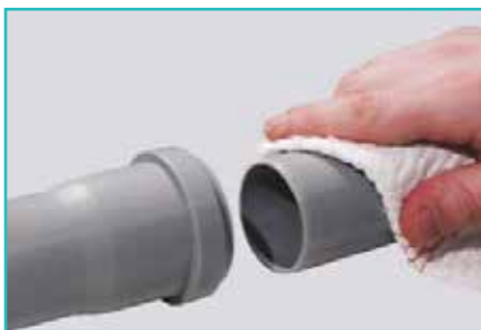
۳ لوله و اتصال را بوسیله یک دستمال تمیز پاک کنید.
