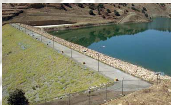
شکل ۳۱: انواع پوشش شیروانی پائین دست سدهای خاکی
