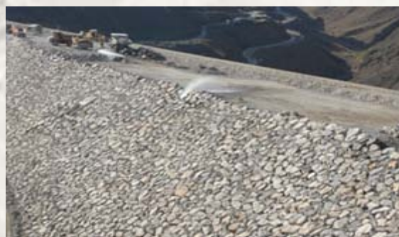
شکل ۳۲: پوشش شیروانی سنگی دستچین
