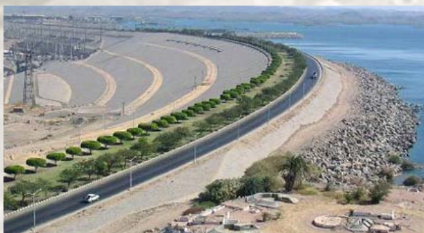
شکل ۲۵: نمایی از تاج سد در سدهای خاکی
