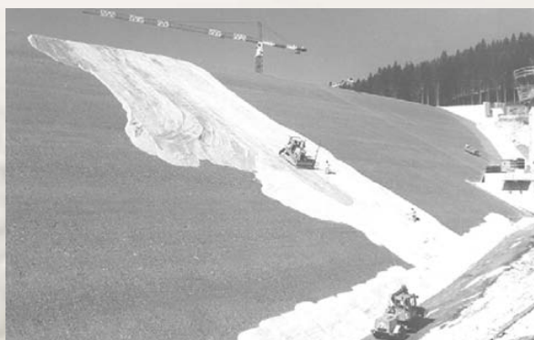
شکل ۴۵: اجرای لایه ژئوتکستایل بر روی بستر آماده شده
