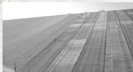
شکل ۴۶: اجرای لایه ژئوممبرین بر روی لایه ژئوتکستایل اجرا شده
