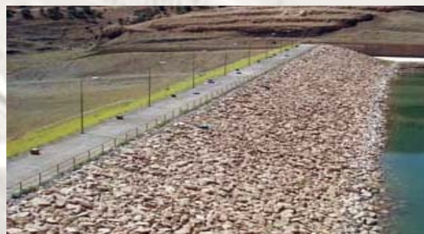
شکل ۲۵: نمایی از تاج سد در سدهای خاکی
