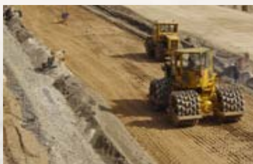
شکل ۵۲: استفاده از غلتک های پاچه بزی در آخرین مرحله تراکم هر لایه هسته رسی
