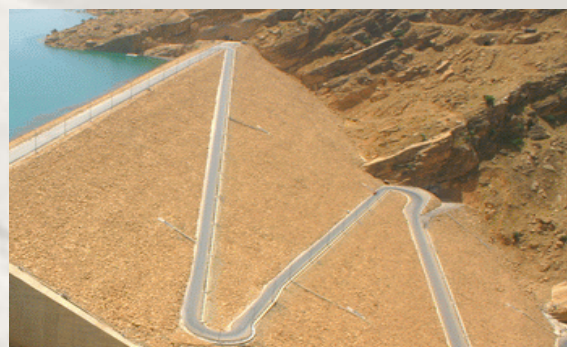
شکل ۳۱: انواع پوشش شیروانی پائین دست سدهای خاکی
