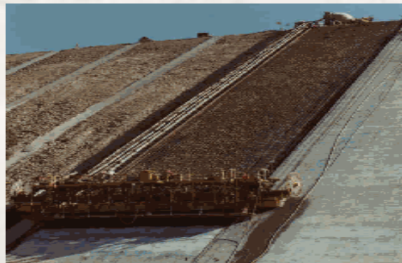
شکل ۳۴: پوشش شیروانی بالادست با استفاده از دالهای بتنی
