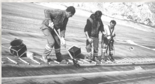
شکل ۴۶: اجرای لایه ژئوممبرین بر روی لایه ژئوتکستایل اجرا شده
