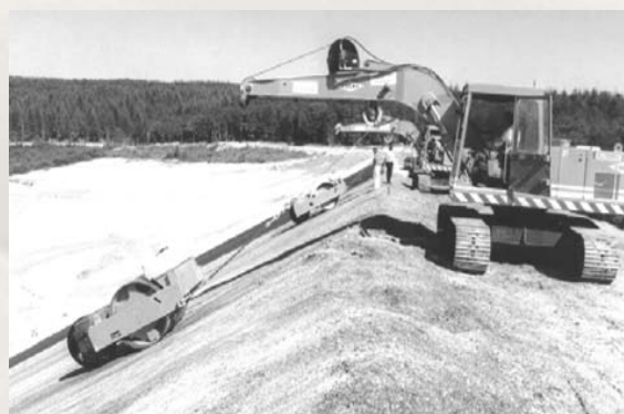
شکل ۴۴: اجرا و تسطیح بستر پوشش محافظ
