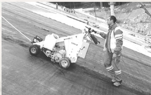
شکل ۴۸: کنترل جوش خوردگی لایه ژئوممبرین
