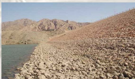
شکل ۳۳: پوشش شیروانی سنگی ریخته شده
