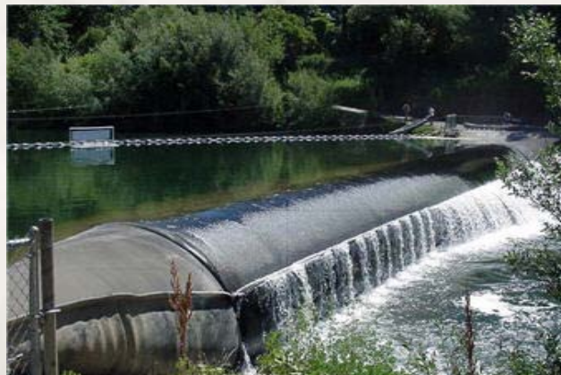
شکل ۱۱: نما و مقطعی از سدهای لاستیکی
