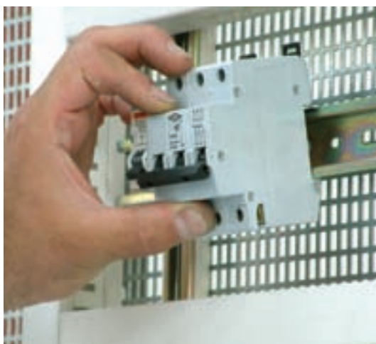
طرز قرارگیری فیوز روی ریل
