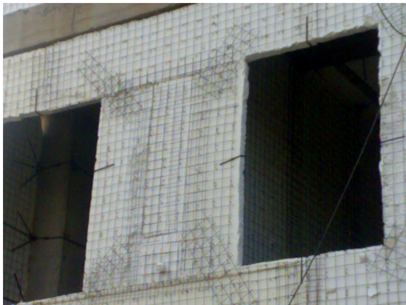
شکل ۱۱: برای عایق‌بندی دیوار از یونولیت استفاده می‌شود.
