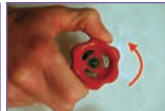
ح - باز کردن شیر فلکه اصلی
