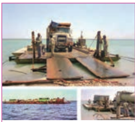
شکل ۱۸-۳- تصاویری از پل خضر
