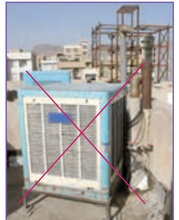
ب - فاصله بین دودکش تا کولر آبی و یا پ - برای خروجی دودکش هر دستگاه گازسوز یک کلاهک H نصب شود. دریچه های تأمین هوای ساختمان دست کم سه متر باشد.
