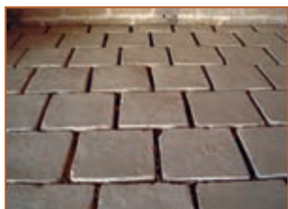
ب- استفاده از آجر برای کف
