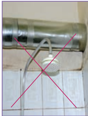
ت - عبور دودکش از داخل حمام یا سقف کاذب آن مجاز نیست.
