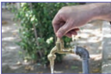
ج- آزمایش نهایی شیر آب (پس از باز کردن شیر اصلی)
