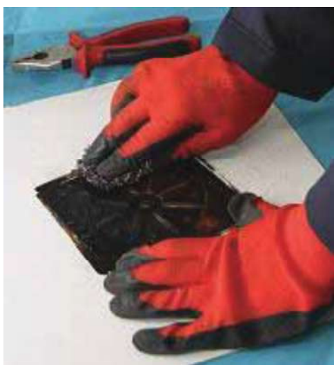
شکل ۱۳-۱۰- ساب زدن سطح پلاک مسی
