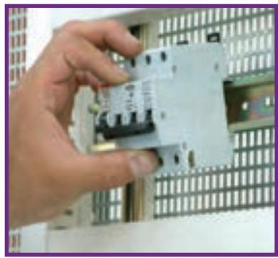
طرز قرارگیری فیوز روی ریل
