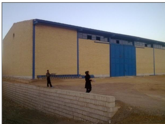
تصویر شماره ۲-۲-۶۵: انبار نمک
