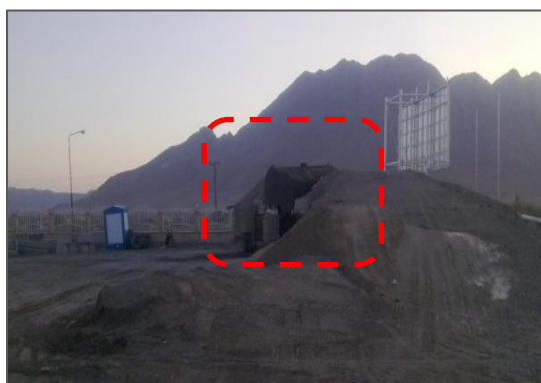
تصویر شماره ۲-۲-۷۳: مخزن سوخت
