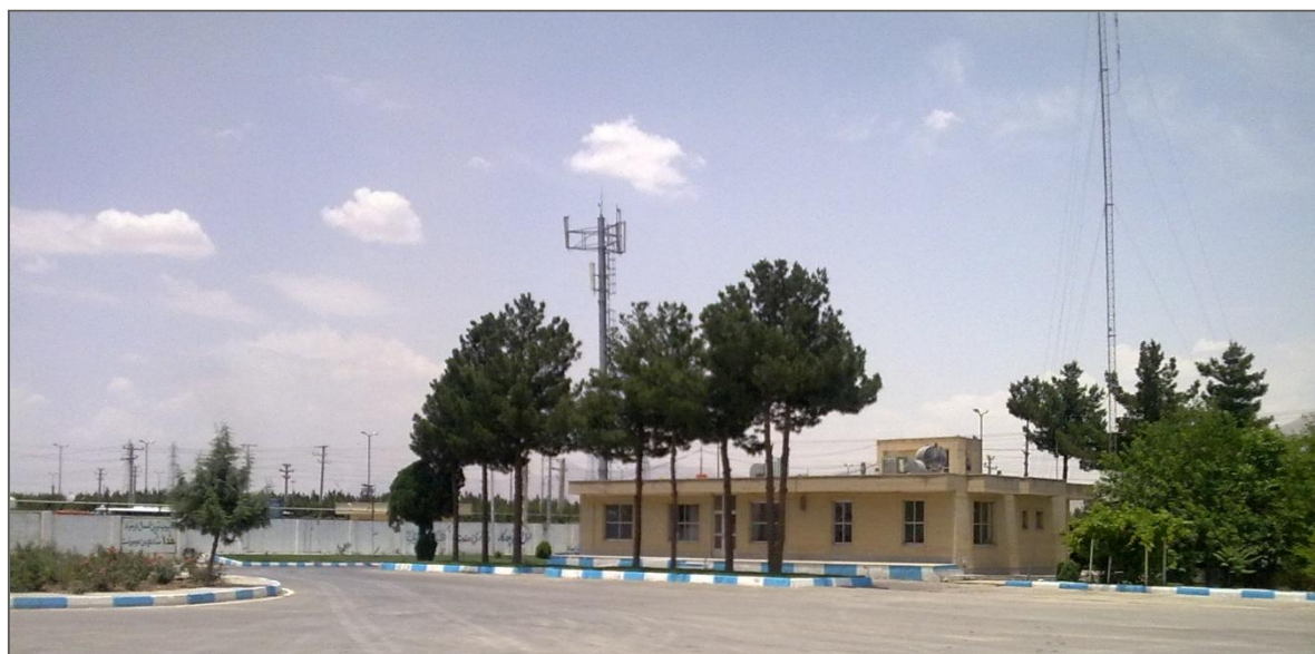
تصویر شماره ۳۳-۲-۲: دید کلی از ساختمان اداره مرکزی زرین شهر
