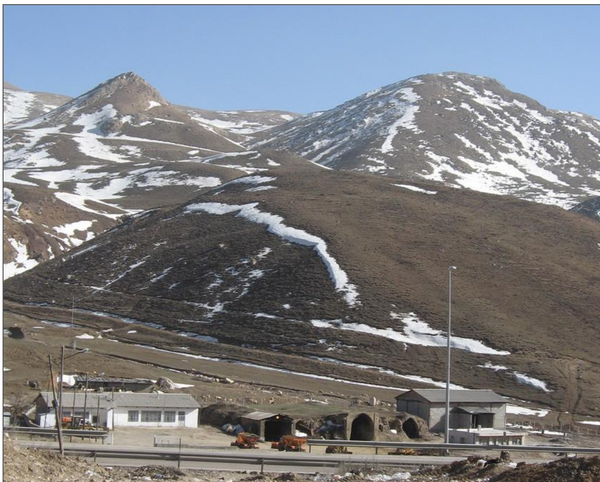
تصویر شماره ۲-۱-۱۹: دید کلی از راهدارخانه گدوک
