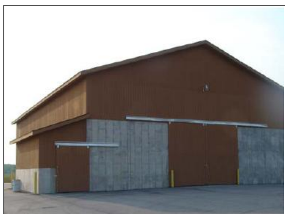
تصویر شماره ۳-۷-۲۷: انبار نمک
