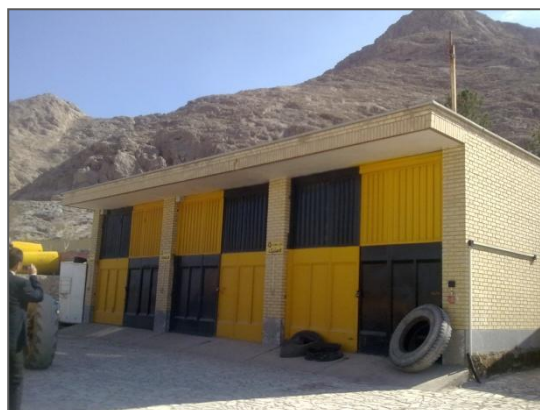
تصویر شماره ۲-۲-۹۱: انبار
