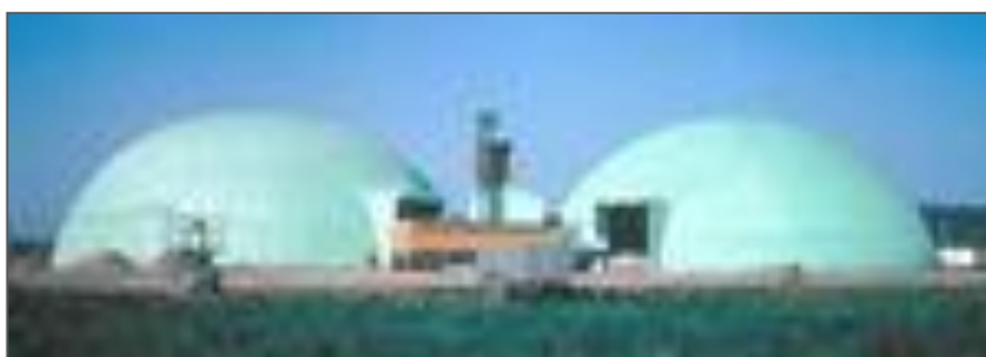
تصویر شماره ۳-۷-۱۷: انبار نمک گنبدهای دوقلو شرکت فورد موتور، تولسا، اکلاهما
