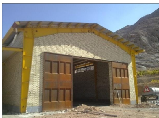
تصویر شماره ۲-۲-۸۵: انبار نمک
