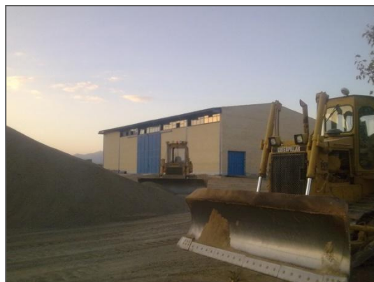
تصویر شماره ۲-۲-۶۴: انبار نمک
