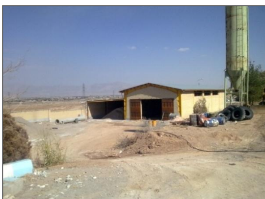
تصویر شماره ۲-۲-۸۴: انبار نمک
