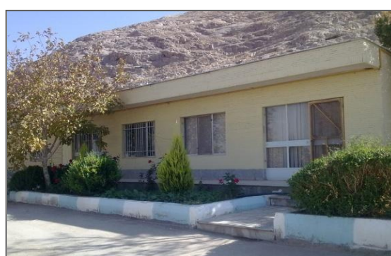
تصویر شماره ۲-۲-۸۰: ساختمان اداری- اقامتی
