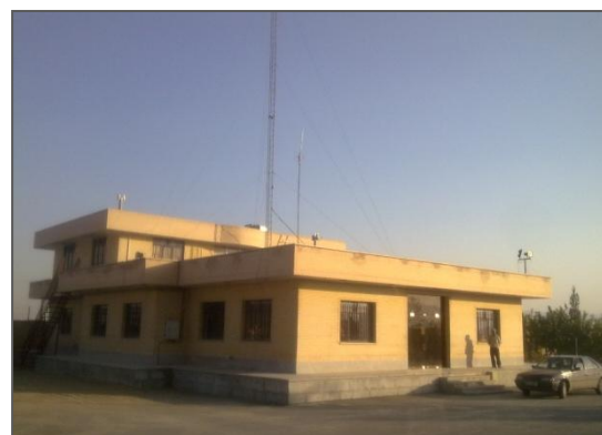
تصویر شماره ۲-۲-۴۵: ساختمان اداری - اقامتی
