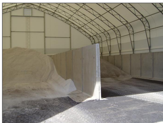
تصویر شماره ۳-۷-۳۱: انبار نمک
