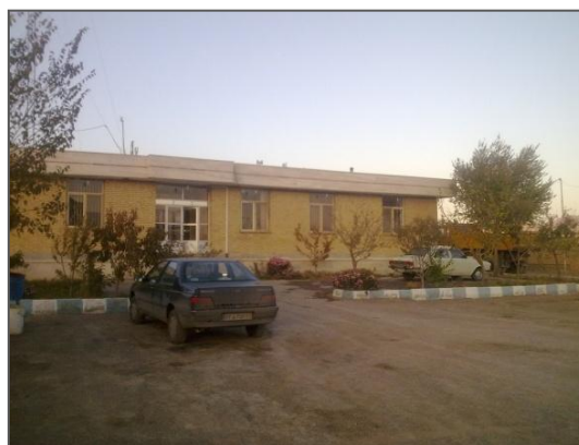
تصویر شماره ۲-۲-۶۲: ساختمان اداری- اقامتی
