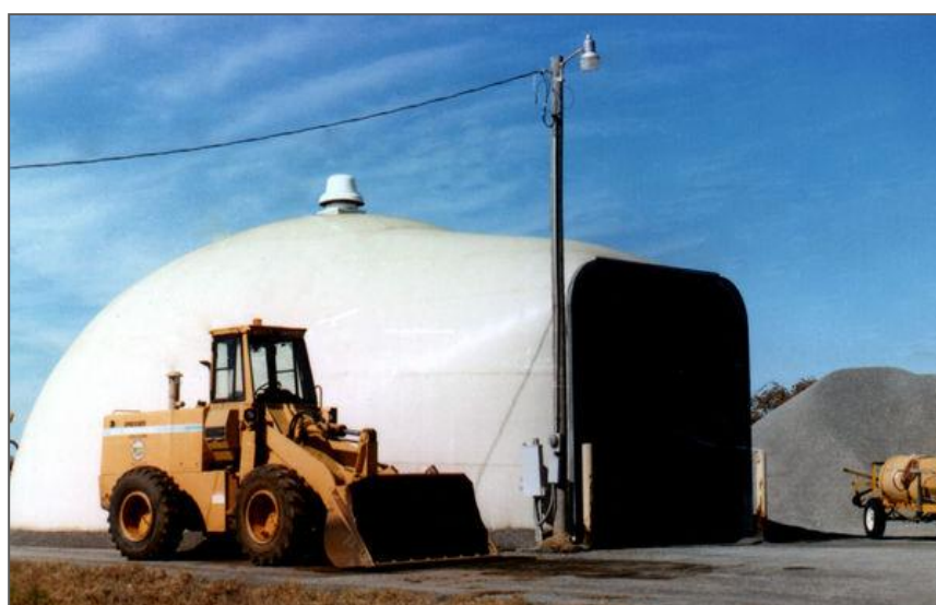
تصویر شماره ۳-۷-۱۴: انبار نمک نزدیکی تکسوما، اکلاهما
