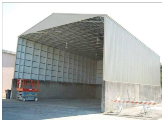
تصویر شماره ۳-۷-۲۸: انبار نمک
