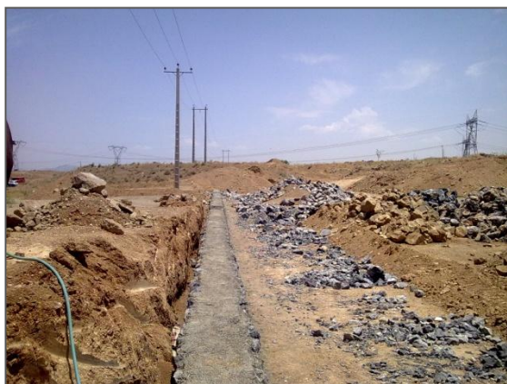
تصویر شماره ۲-۲-۳۲: دیوار محوطه
