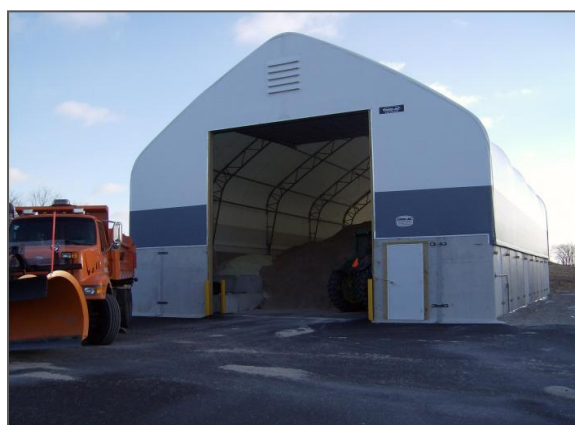
تصویر شماره ۳-۷-۳۴: انبار نمک
