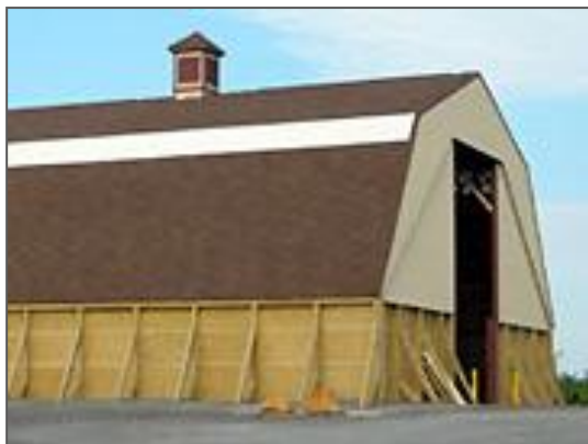
تصویر شماره ۳-۷-۳: انبار نمک
