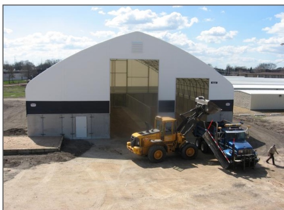
تصویر شماره ۳-۷-۳۲: انبار نمک
