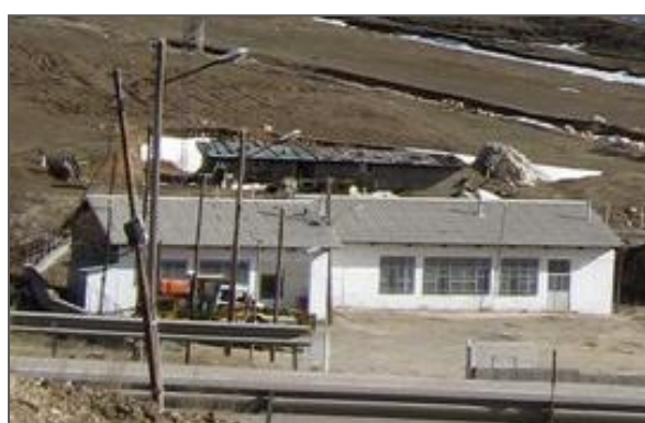
تصویر شماره ۲-۱-۲۲: ساختمان اداری
