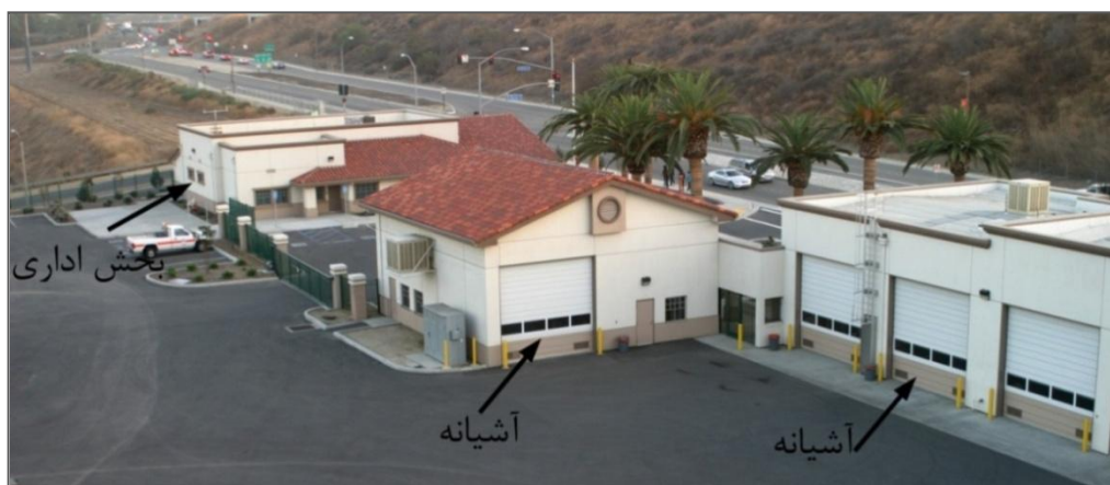
تصویر شماره ۳-۳-۳: ساختمان آشپزخانه و خدمات ماشین‌آلات و بخش اداری راهدارخانه
