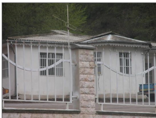
تصویر شماره ۲-۲-۳: ساختمان اداری-اقامتی
