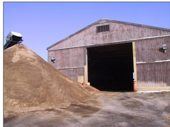
تصویر شماره ۳-۵-۱: انبار نمک
