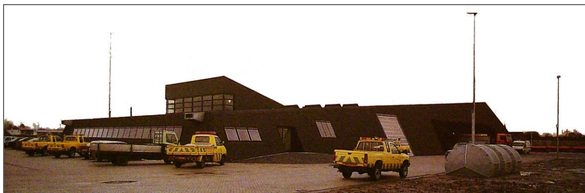
تصویر شماره ۳-۲-۱: دید کلی از راهدارخانه هارلینگن
