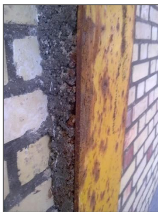
تصویر شماره ۸۸-۲-۲: انبار نمک-زنگ زدن سازه در اثر تماس با نمک
