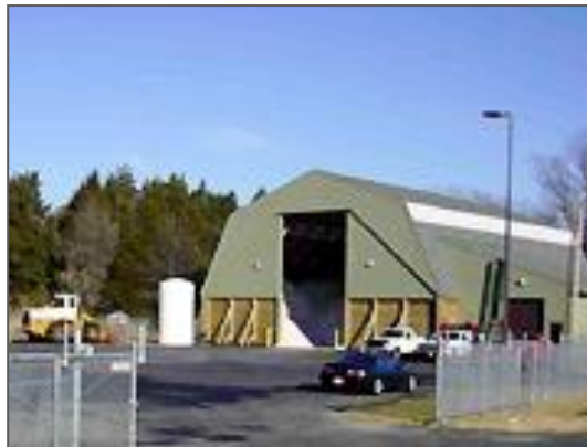
تصویر شماره ۲-۷-۳: انبار نمک
