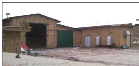
تصویر شماره ۸-۱-۲: انبار شن و نمک
