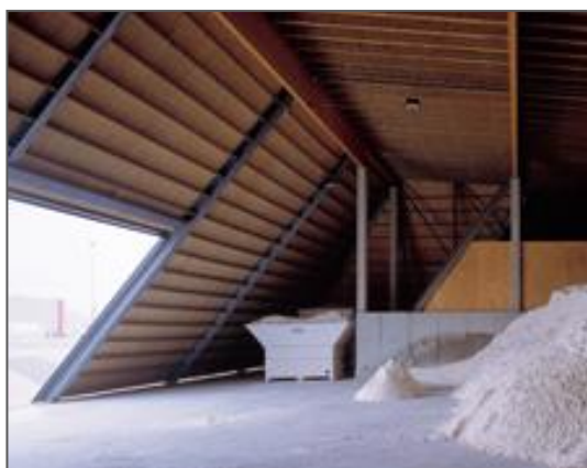
تصویر شماره ۳-۲-۳: انبار نمک
