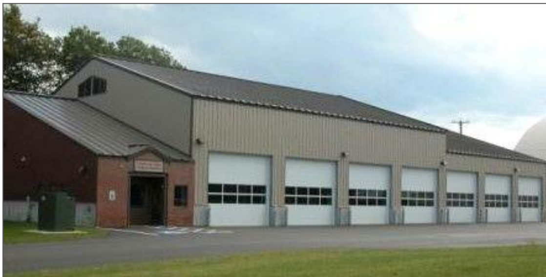
تصویر شماره ۳-۶-۱: ساختمان اداری و آشیانه ماشین‌آلات
