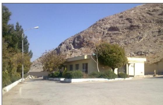
تصویر شماره ۲-۲-۸۱: ساختمان اداری- اقامتی
