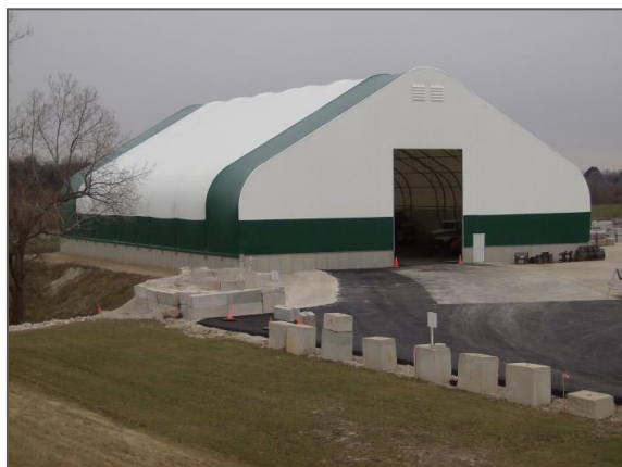
تصویر شماره ۳-۷-۲۲: انبار نمک
