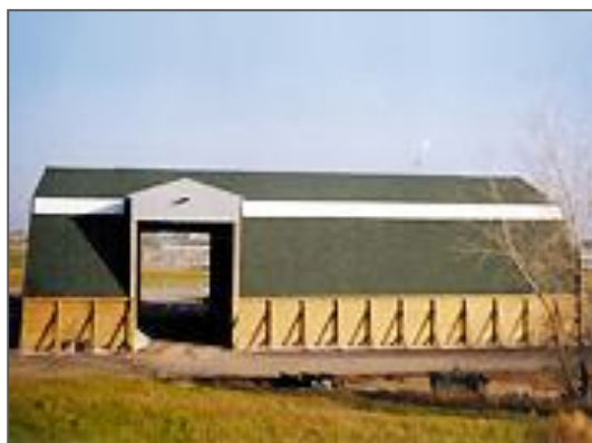
تصویر شماره ۴-۷-۳: انبار نمک
