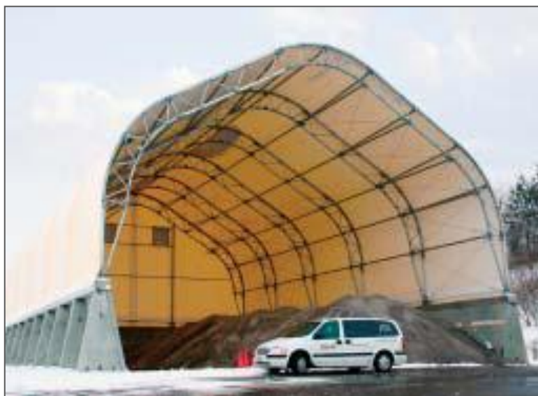
تصویر شماره ۳-۷-۲۵: انبار نمک
