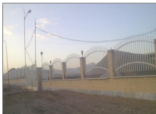
تصویر شماره ۲-۲-۷۲: دیوار محوطه
