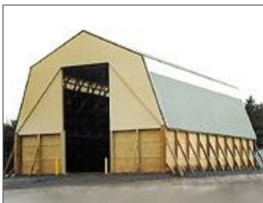
تصویر شماره ۷-۷-۳: انبار نمک
