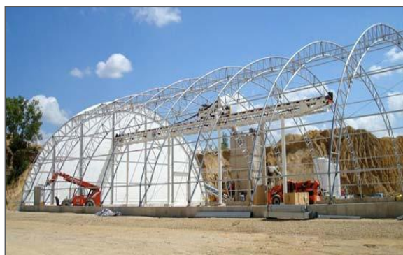
تصویر شماره ۳-۷-۱۹: انبار نمک در حال ساخت
