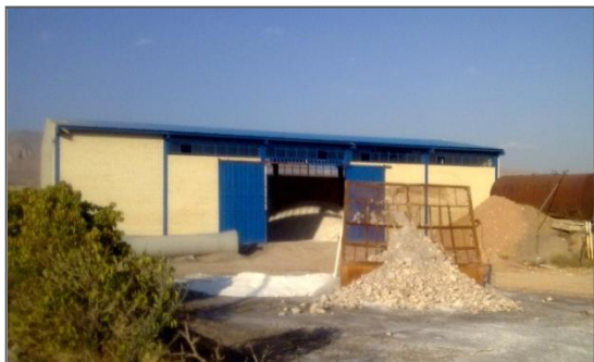
تصویر شماره ۲-۲-۴۸: انبار نمک
