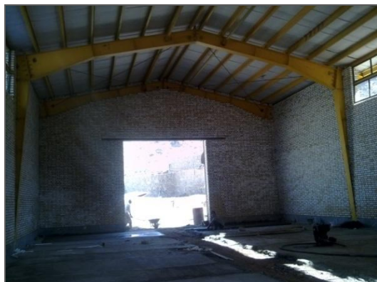
تصویر شماره ۸۷-۲-۲: انبار نمک
