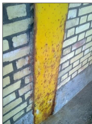
تصویر شماره ۸۸-۲-۲: انبار نمک-زنگ زدن سازه در اثر تماس با نمک
