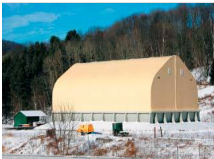
تصویر شماره ۳-۷-۲۴: انبار نمک با عرض حدود ۱۵ تا ۱۸ متر و ارتفاع حدود ۲۷ متر
