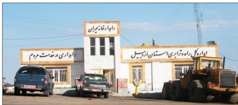
تصویر شماره ۲-۱-۱۶: ساختمان اداری-اقامتی
