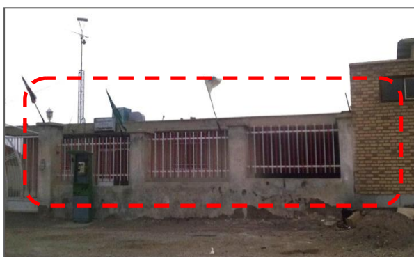
تصویر شماره ۱۲-۱-۲: همجواریها (ساختمان امداد)
