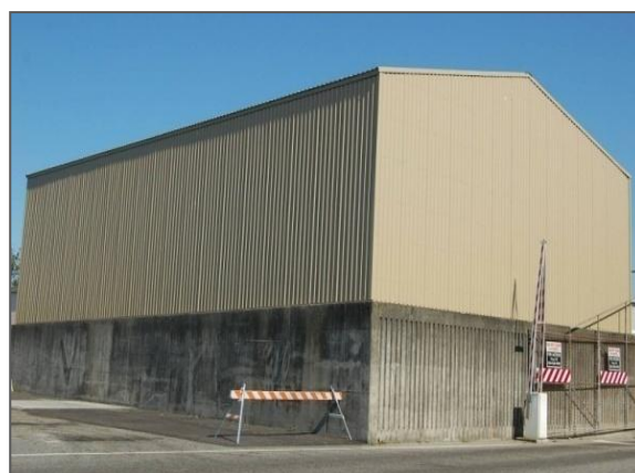
تصویر شماره ۳-۷-۲۶: انبار نمک
