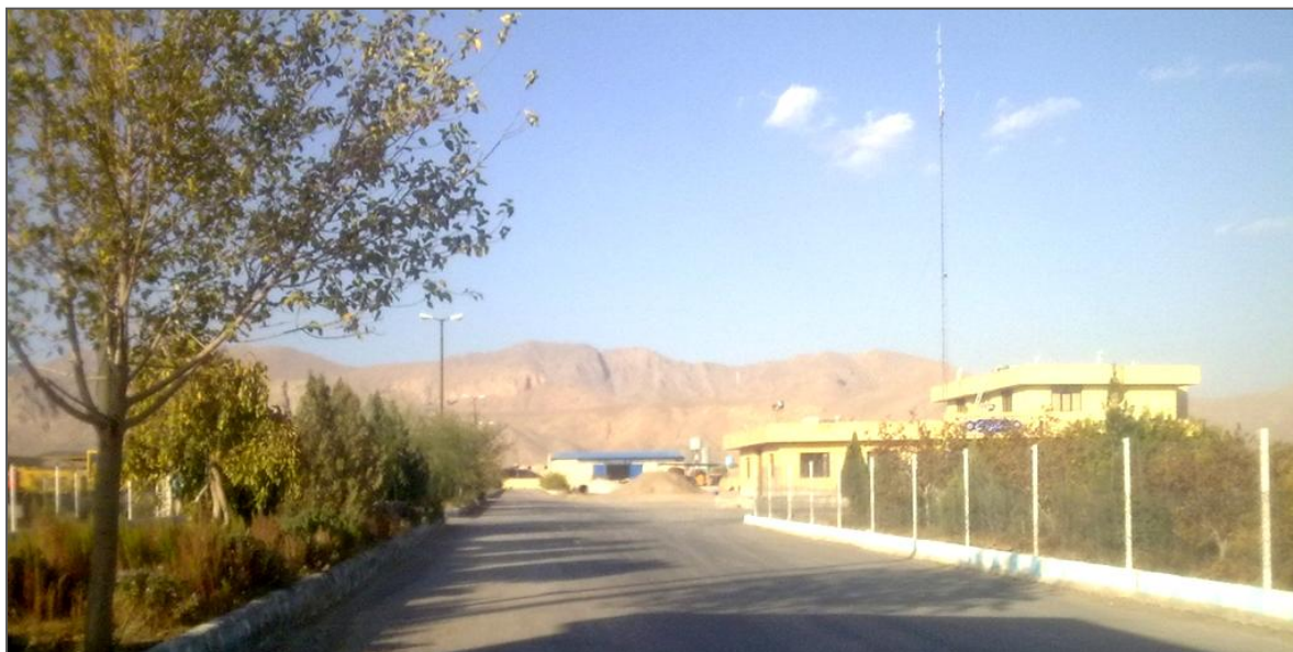
تصویر شماره ۲-۲-۴۴: دید کلی از اداره مرکزی نجف آباد
