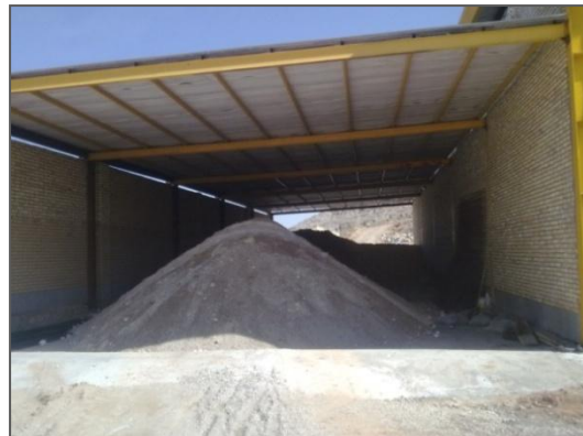
تصویر شماره ۸۶-۲-۲: فضای داخلی - انبار نمک
