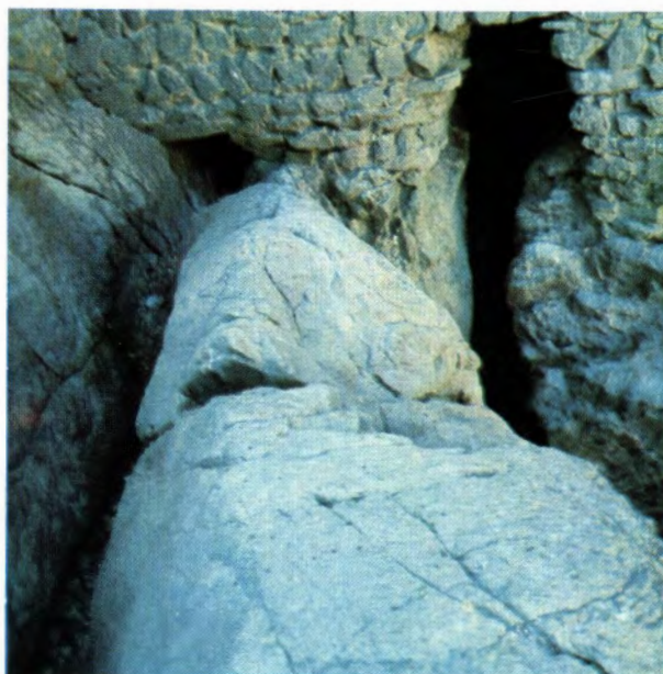
شکل ۱۶۶ - محل خروج آب از بدنه سد و نهرکنده شده در سنگ کوه که به احتمال قوی آبشارهای کاروانسرائی که در ۳ کیلومتری بند قرار گرفته مشروب میساخته است .
