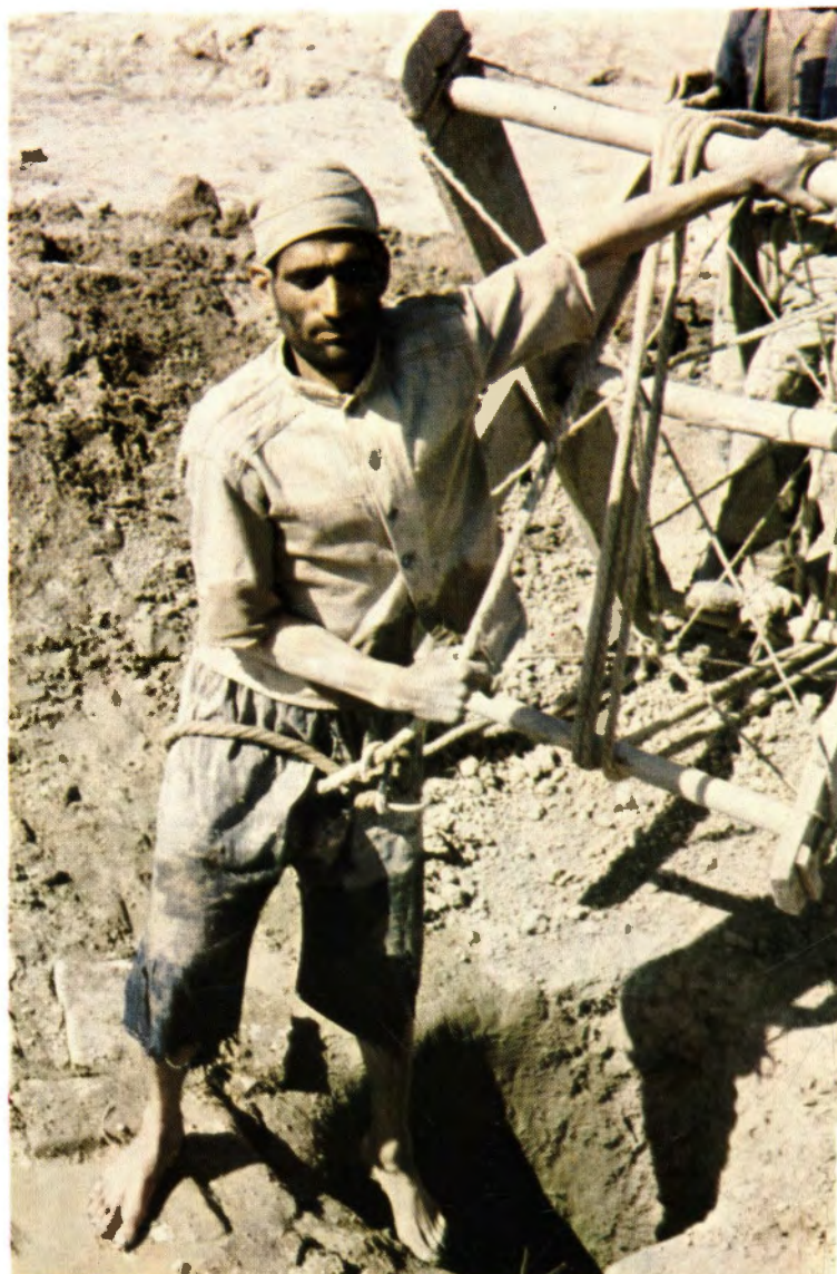
شکل ۷۶ - مقنی آماده پائین رفتن در چاه است
