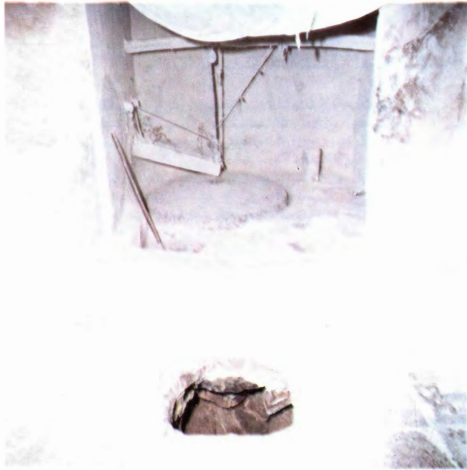
شکل ۱۳۶ - سنگ روئین آسیاب ، ناودون حمل غله و محل جمع شدن آرد و در گوشه راست تخته بند کشوئی آسیاب دیده میشود.
