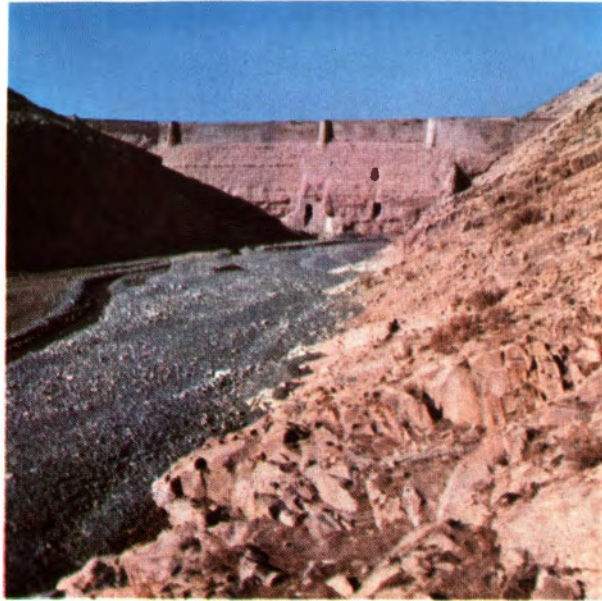
شکل ۱۸۱ - بند طرق در مشهد (عمر در حدود ۴۰۰ سال) نما از طرف زیرآب . از عکس بخوبی مشهود است که بند در دو مرحله ساخته شده است.
