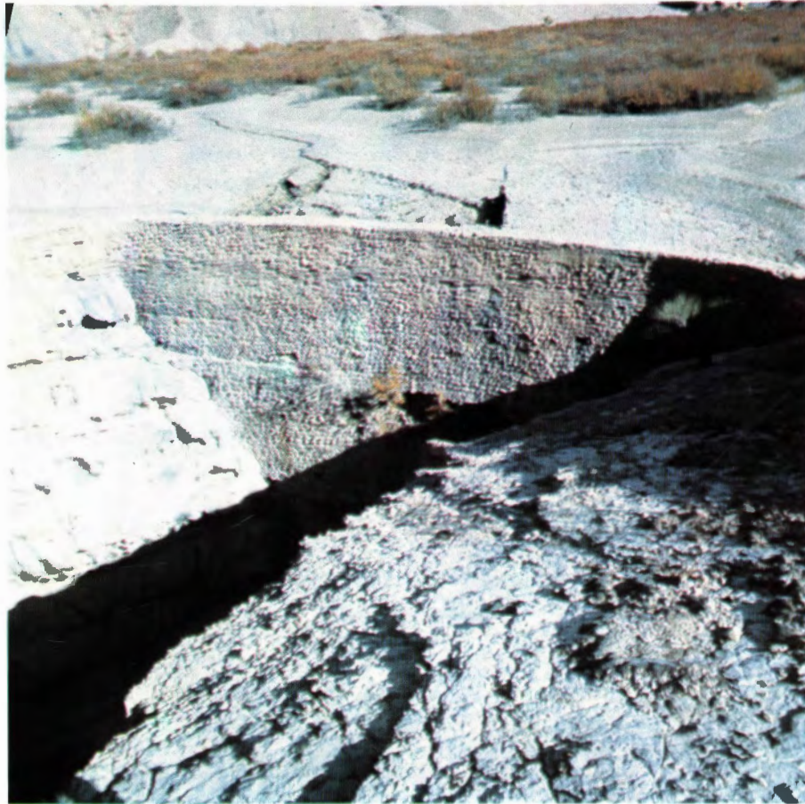
شکل ۱۷۶ - بند کریت در طبس ، قوسی است و ارتفاع آن بیش از یکصد متر است . مخزن سد پر شده است (عمر در حدود ۴۰۰ سال)
