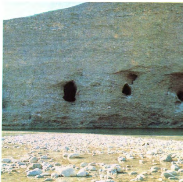
شکل ۱۵۰ - آبگیر های واقع در سراب بند ارگان که بصورت سفته (قنات) ساخته شده اند.
