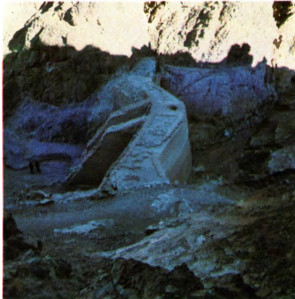
شکل ۱۸۸ - بند عمر شاه در بیرجند . بند قوسی و دارای دو ستون در وسط میباشد.
