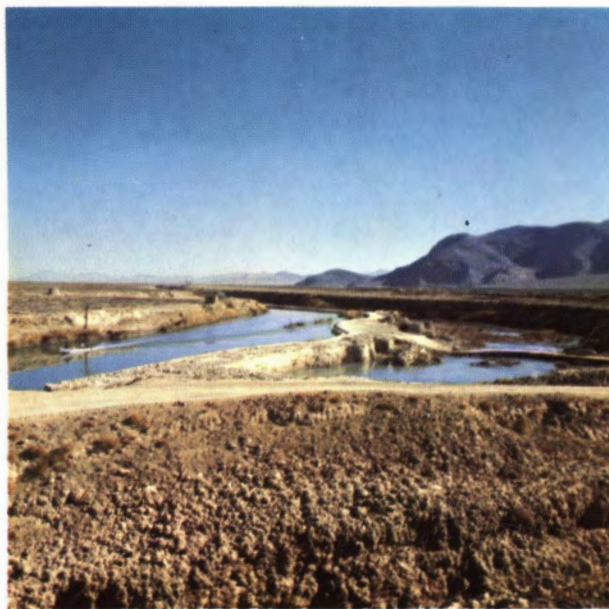
شکل ۱۵۶ - بند فیض‌آباد که بصورت کنار بند رودخانه ساخته شده است (عمر در حدود ۱۰۰۰ سال)
