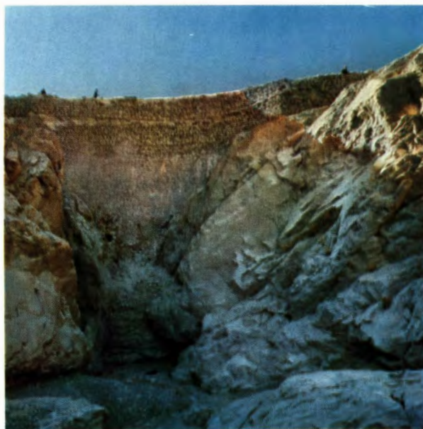
شکل ۱۶۵ - سد کبار قم، سد قوسی است (عمر در حدود ۷۰۰ سال) دید از طرف زیر آب
