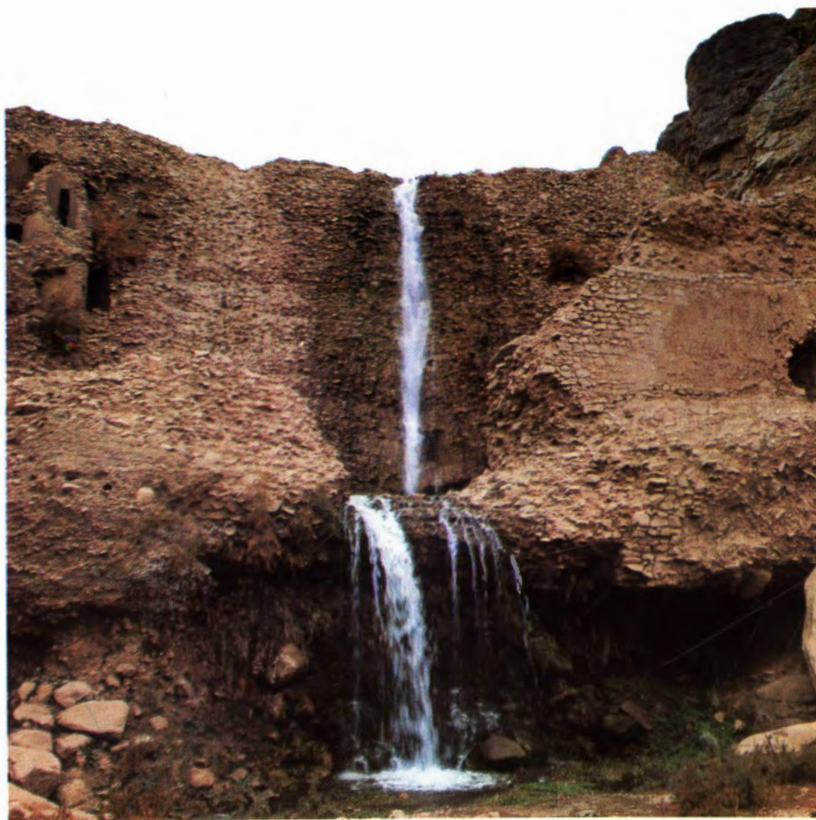
شکل ۱۹۰ - بند قمصر که مخزن آن پر و بدنه سد نیز خراب شده است . عکس بخوبی کیفیت بتون بکار برده شده را نشان میدهد . در وسط عکس برج آبگیر را می بینیم که از آجر ساخته شده است و اطراف آن پله حلزونی قرار دارد .
