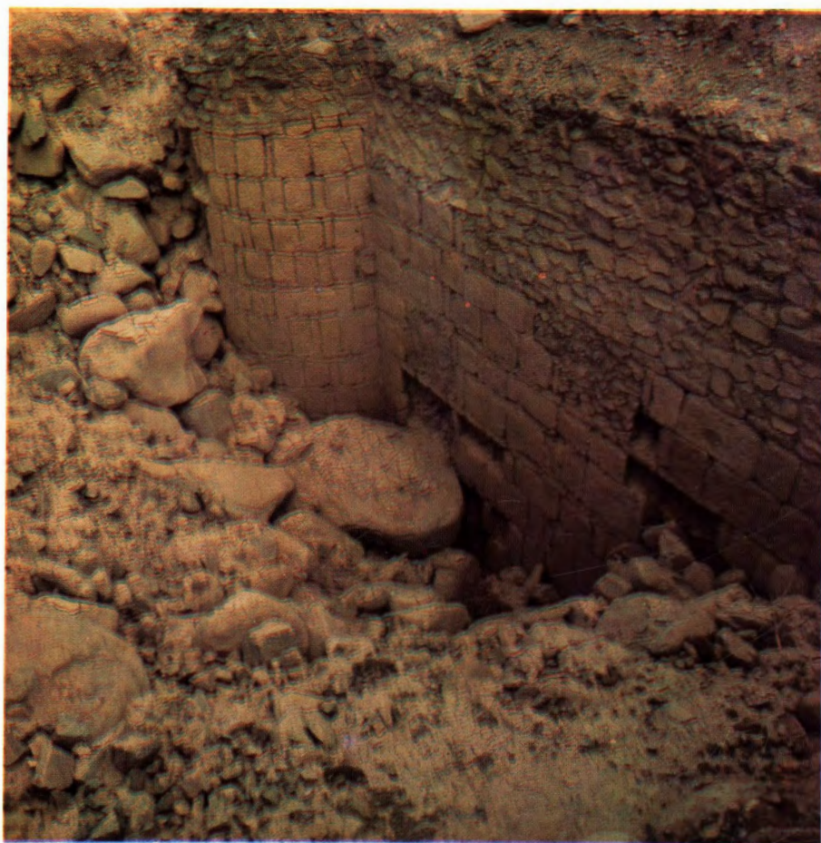
شکل ۱۹۲ - پی‌ریزی سد مخروبه قمصر . از این عکس نمایان است که در شالوده‌ریزی سد ها ایرانیان باستان نهایت دقت را بکار می‌برده‌اند.
