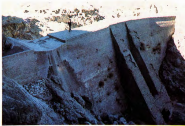
شکل ۱۸۵ - بند دره در بیرجند ، نما از طرف زیرآب ، رسوبات گل ولای مخزن در عکس بخوبی دیده میشود
