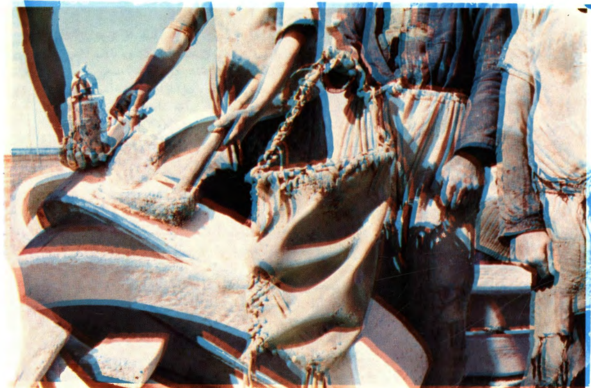
شکل ۷۱- وسایل کار مقنیان عبارتست از : چراغ روغنی ، کلنگ . دلو چرمی و یک کجبیل دسته کوتاه
