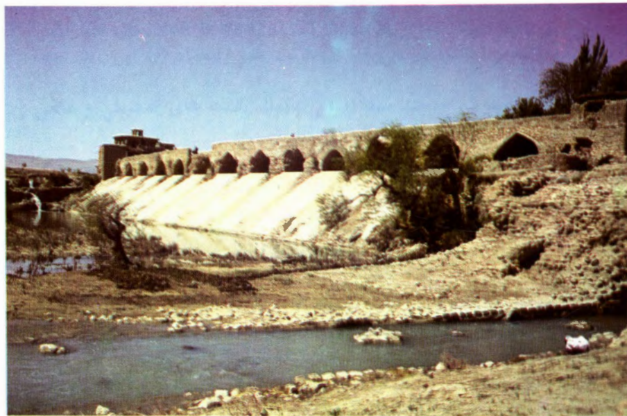
شکل ۱۹۷ - حوض آرامش طبیعی در بند امیر ، آب پس از عبور از روی بدنه سد به یک تشک آبی که در پای آن بطور طبیعی تشکیل شده برخورد کرده و بدین ترتیب آرامش مییابد و همین امر موجب آن شده که بند امیر پس از گذشت هزار سال هنوز قابل بهره‌برداری است.
