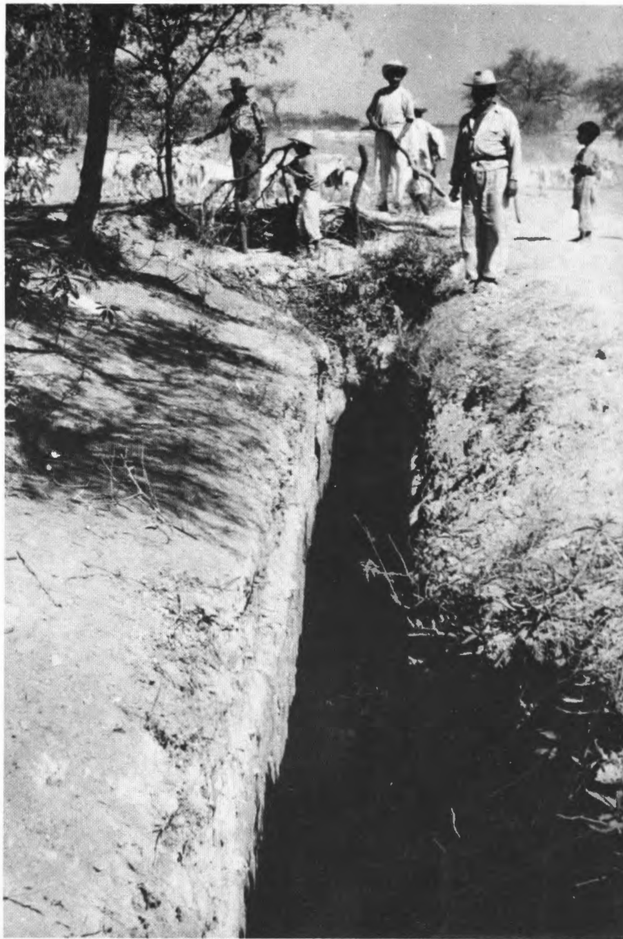
شکل ۸۸ - در عکس میله های قنات واقع در مکزیک در آبادی کوآپان دیده میشوند ، بومیان مکزیک میله ها را «دودکش» (Lumbreras) و پیشکار قنات را گالری نفوذی (Galeria Filtrante) مینامند.
