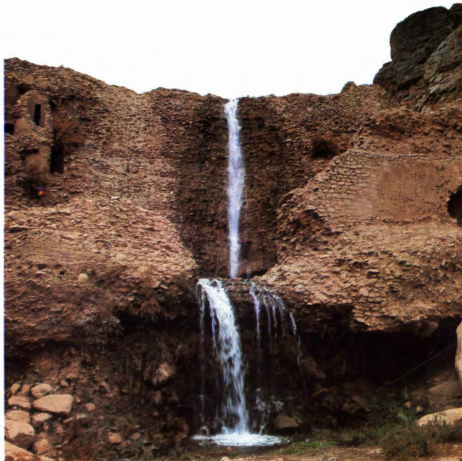
شکل ۱۹۰ - بند قمصر که مخزن آن بر وبدنه سد نیز خراب شده است . عکس بخوبی کیفیت بتون بکار برده شده را نشان میدهد. در وسط عکس برج آبگیر را می بینیم که از آجر ساخته شده است و اطراف آن پله حلزونی قرار دارد .
