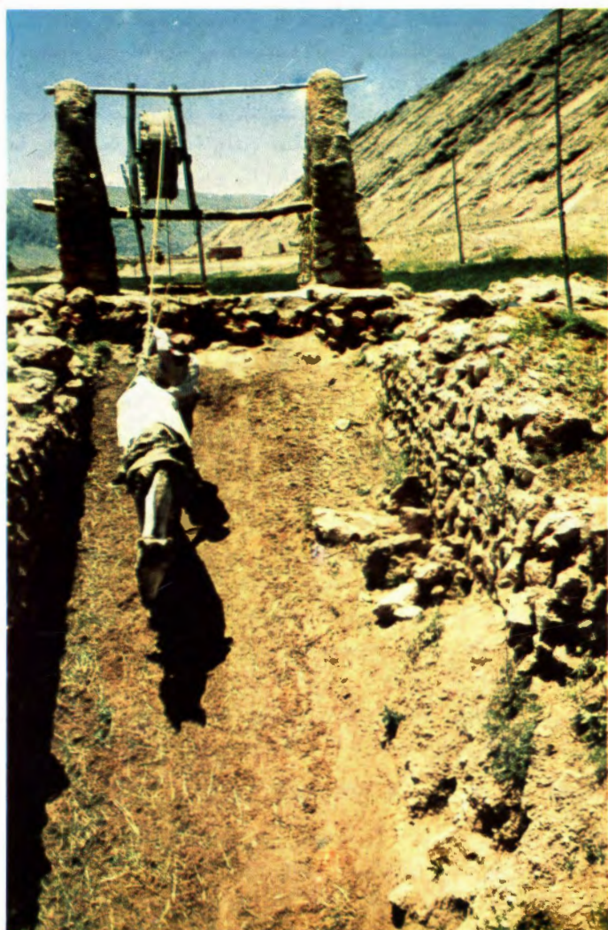
شکل ۶۲ - طریقه آبکشی از چاه بوسیله نیروی حیوانی همانطوریکه مشاهده میشود بجای گاو ، از اسب برای آبکشی از چاه استفاده میشود (عکس در سال ۱۳۴۲ در نزدیکی تخت جمشید برداشته شده است)
