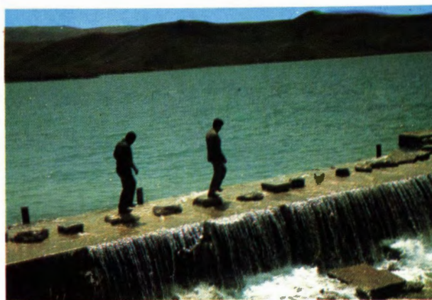
شکل ۱۹۵ - لبریز سد فریمان که در ساحل چپ کنار بند تعبیه شده است .
