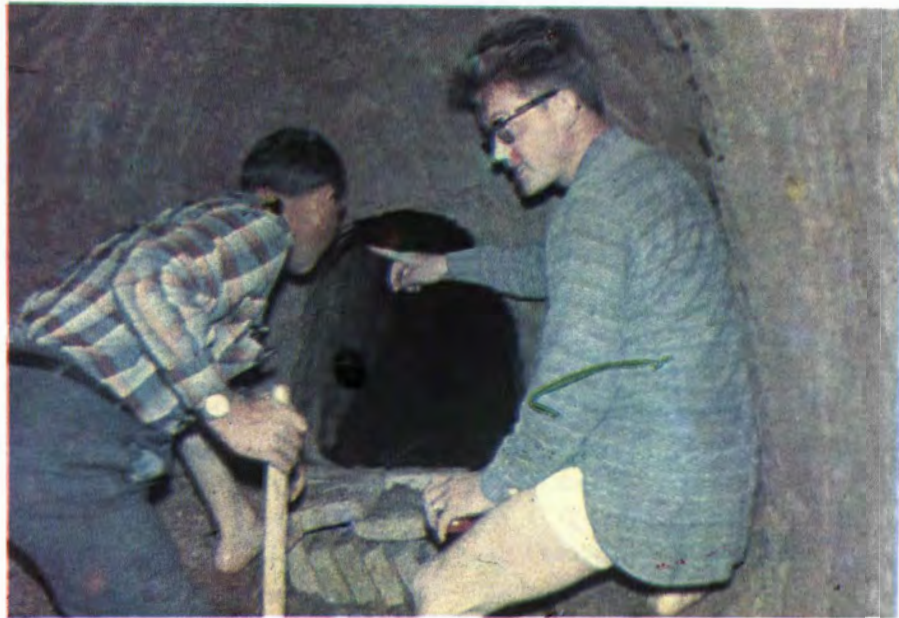
شکل ۶۹ - مقطع پیشکار قنات سبزوار که از آن برای لوله‌کشی شهر استفاده میشود.
