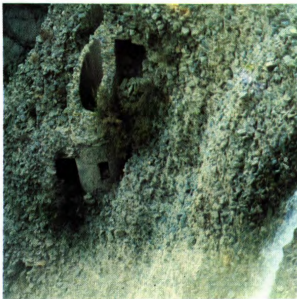
شکل ۱۷۰ - بند قمصر ، نما از زیر آب بتون آهکی سد در این عکس بخوبی نمایان است در وسط بقایای یکی از برجهای آبگیر دیده میشود .
