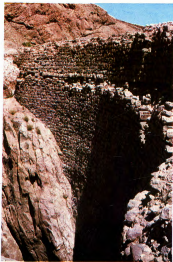
شکل ۱۹۱ - بند قوسی کبار قم . نمونه‌ای است از سه سد قوسی ایران باستان .
