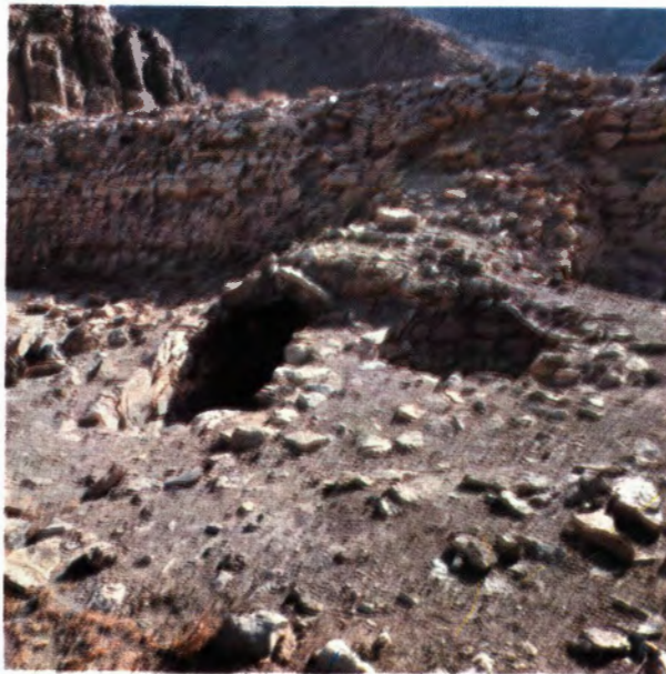
شکل ۱۶۸ - بند قهرود در کاشان دید از سرآب ، مخزن سد باگل و لای پر شده است در قسمت جلو چاه آبگیر دیده میشود.
