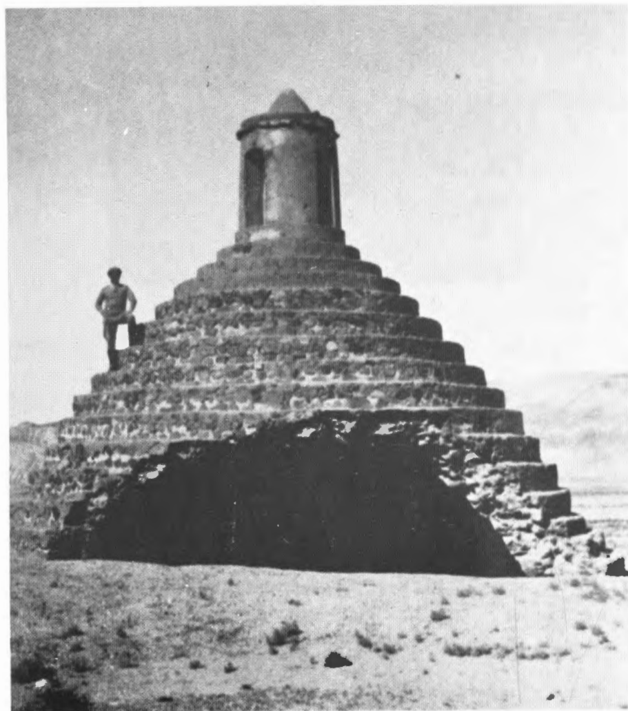
شکل ۹۴ - آب‌انبار مخروبه در کنار کویر روی استوانه منبع‌سقف مخروطی سد بنا شده وهواکش درراس مخروط تعبیه شده است .
