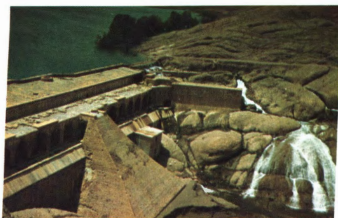
شکل ۱۹۶ - درسد فریمان آبهای طغیانی از دو کنار سد بدون تماس بابدنه بند جاری شده و انرژی خود را بدینترتیب از دست میدهند .
