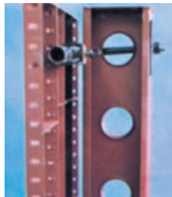
شکل ۷-۱۱- در این عکس یک قالب بدنه، لوله، گیره و پشت‌بند قوی را می‌بینید.
