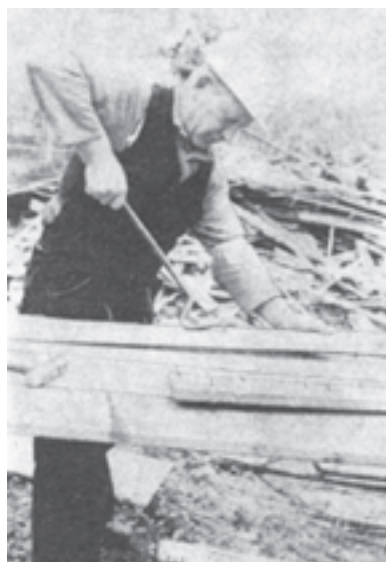
شکل ۱-۳۰ - میخ کشی از تخته توسط میخ کش اهرمی
