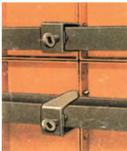
شکل ۱۰-۷- اتصال پشت‌بند ناودانی به بدنه‌ی قالب توسط گیره‌ی بلند
