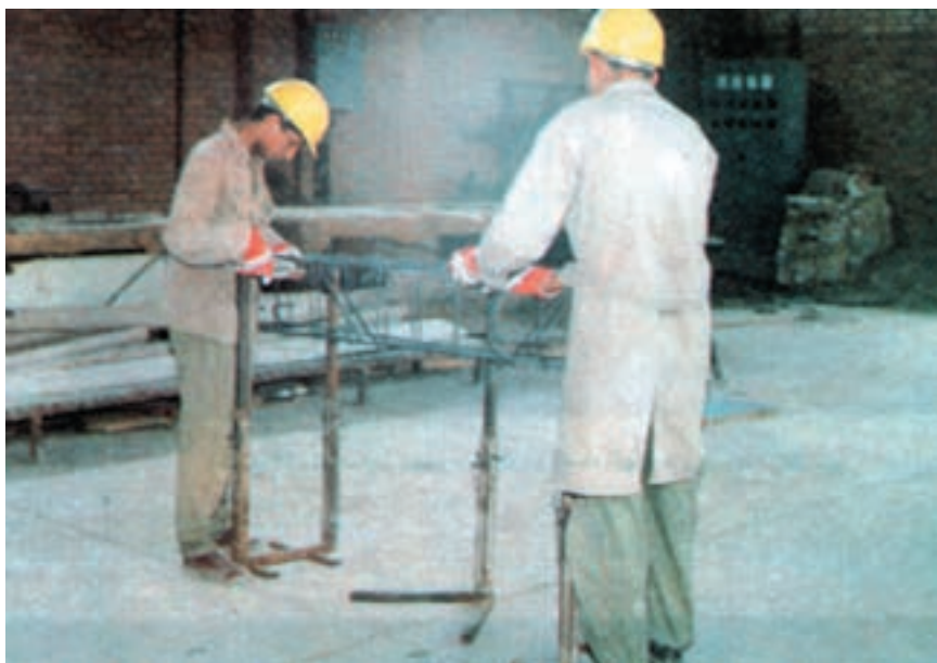
شکل ۱۲-۳- طریقه‌ی مونتاژ آرماتورهای یک پوتر کوچک
