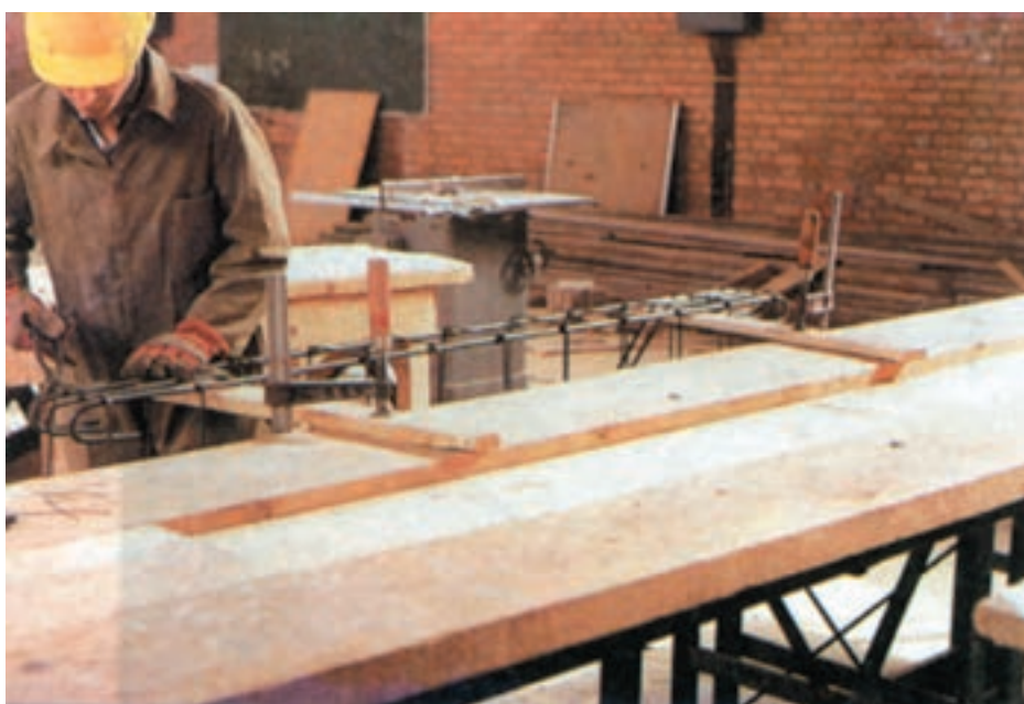
شکل ۲-۹۷- مونتاز میل‌گرد با استفاده از تخته‌هایی که با پیچ‌دستی به میز متصل شده‌اند.
