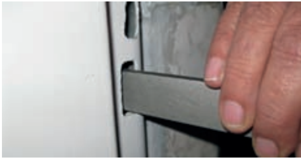
شکل ۱-۴ سوهان کاری زبانه در
