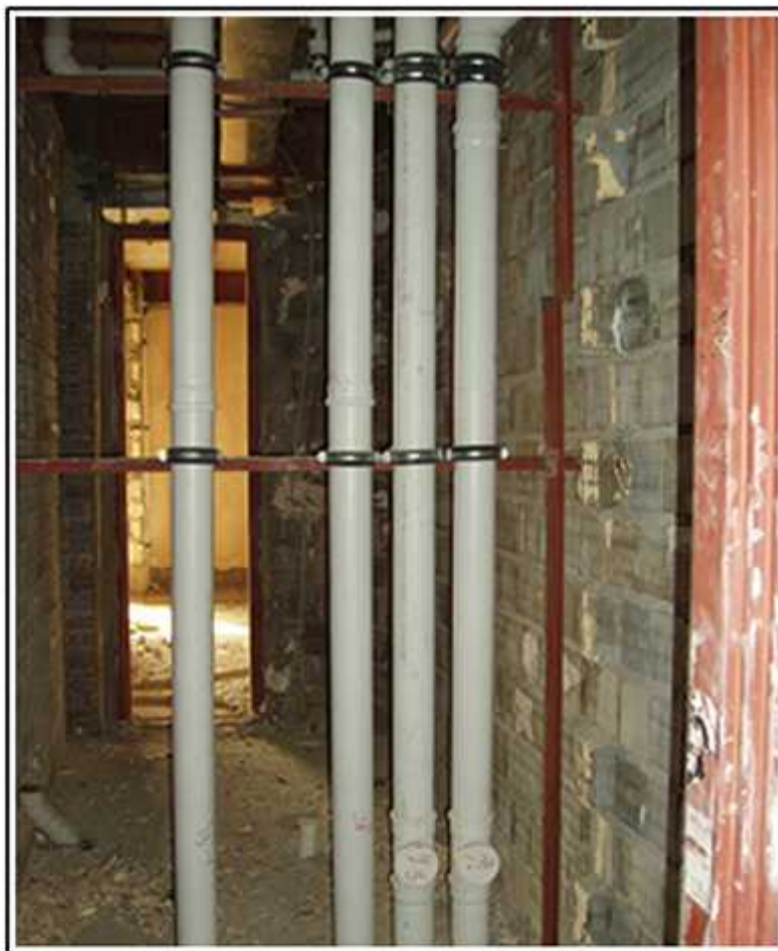
شکل ۴ : طرح شماتیک بست گذاری در سیستم لوله کشی MURI SILENT PIPE در داکت تاسیسات
