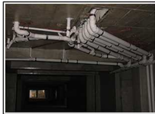
شکل ۴ : طرح شماتیک بست گذاری در سیستم لوله کشی MURI SILENT PIPE در داکت تاسیسات
