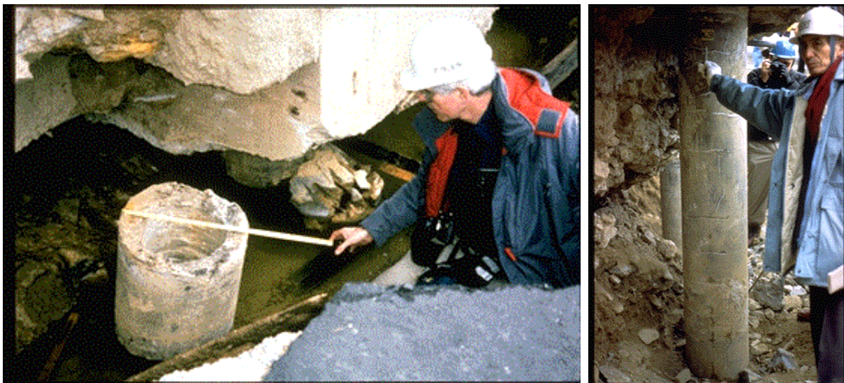
شکل ۲-۸- خرابی شمع‌ها در اثر گسترش جانبی در طی زلزله‌ی کوبه در ژاپن
