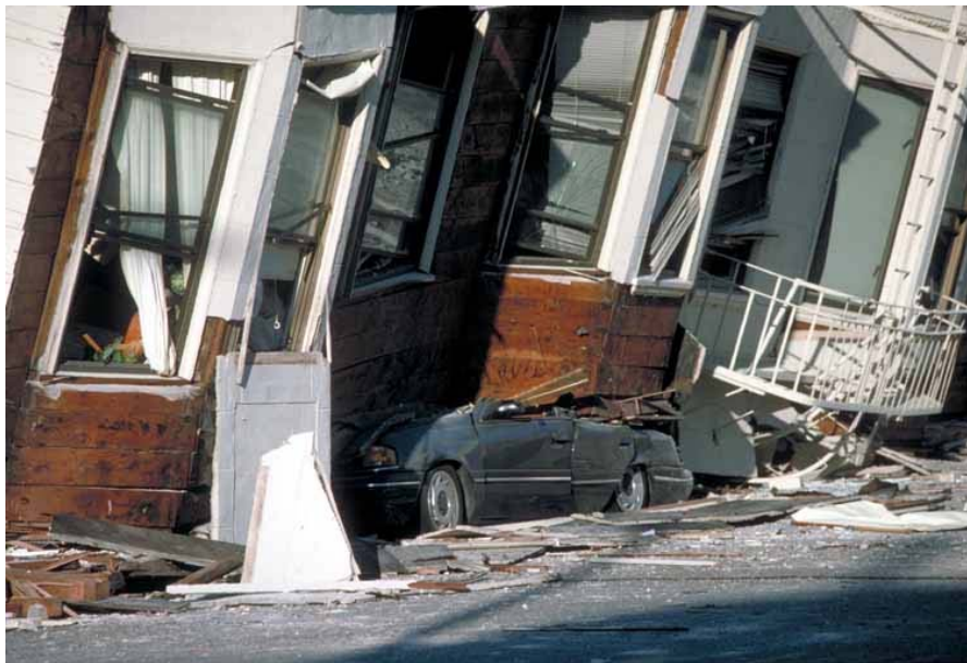
شکل ۱-۱۰- فرورفتن ساختمان در اثر روانگرایی در ناحیه‌ی ساحلی Marina در زلزله‌ی Loma Prieta
