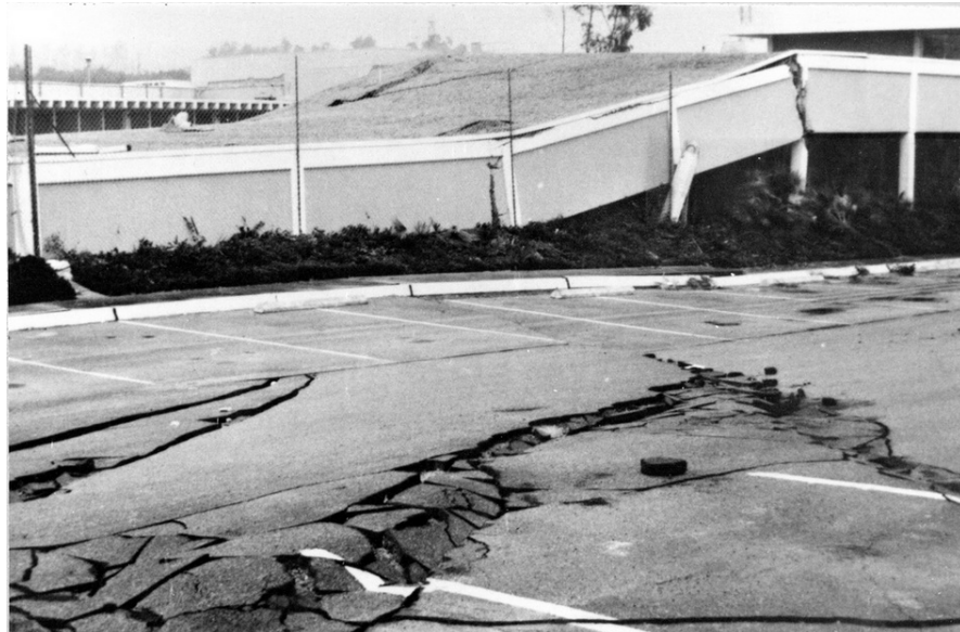
شکل ۱-۹- تغییر مکان زمین ناشی از گسترش جانبی در منطقه‌ی Juvenile Hall در طی زلزله‌ی San Fernando
