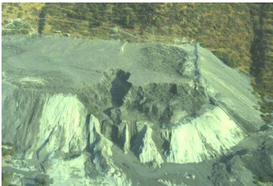
شکل ۲-۳- گسیختگی سد باطله در Cerro Negro شیلی در زلزله‌ی سال ۱۹۸۵
