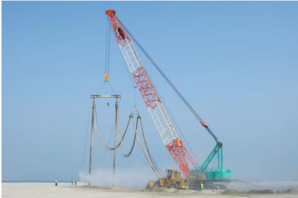
شکل ۸-۸- وسیله‌ی ارتعاشی آویزان از یک جرثقیل معمولی
