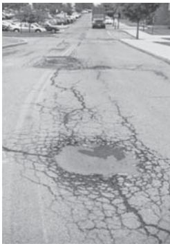
Fatigue crack
