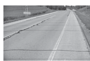
Thermal cracking
