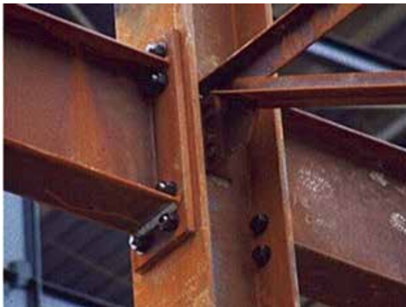
الف- ستون با مقطع نیمرخ نورد شده تیر آهن بال پهن (IPB)
