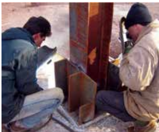
شکل ۴-۲۶- جوشکاری کامل پای ستون و ملمقات آن
