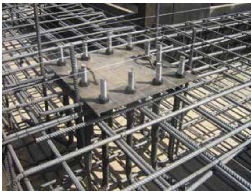
شکل ۳-۱۲- تنظیم پیچ‌های مهاری با شابلن و ریسمان
