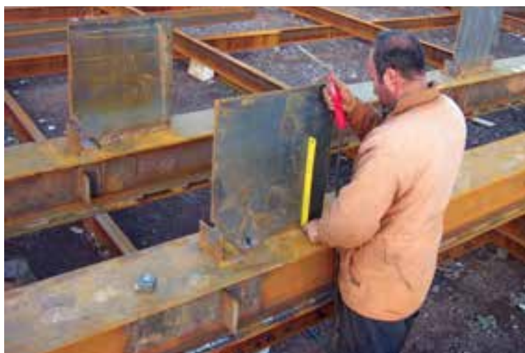
شکل ۴-۲۲- نصب مملقات ستون روی شاسی‌های مونتاژ
