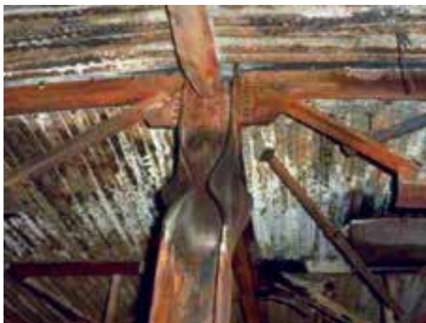
شکل ۴-۵- کمانش موضعی ستون
