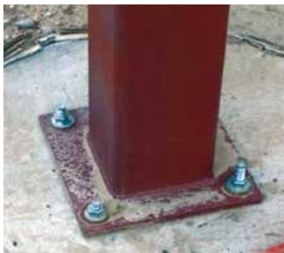
ب- ستون با مقطع قوطی شکل شکل ۴-۶- مقطع تیر آهن بال پهن و قوطی شکل در ستون‌ها
