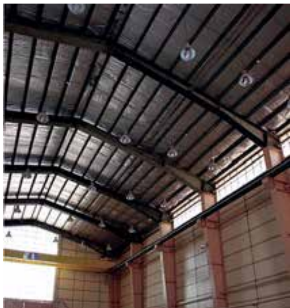
شکل ۴-۱۳- نمونه‌هایی از ستون‌های سالن‌های صنعتی
