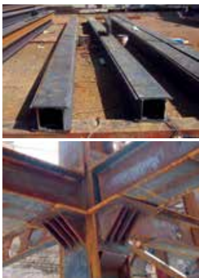
شکل ۴-۱۶- ستون دابل با ورق تقویتی یکسره
