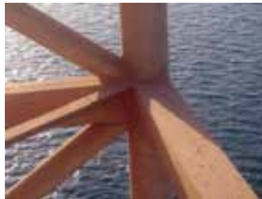
ستون با مقطع دایره در یک سازه صنعتی در جزیره فارک
