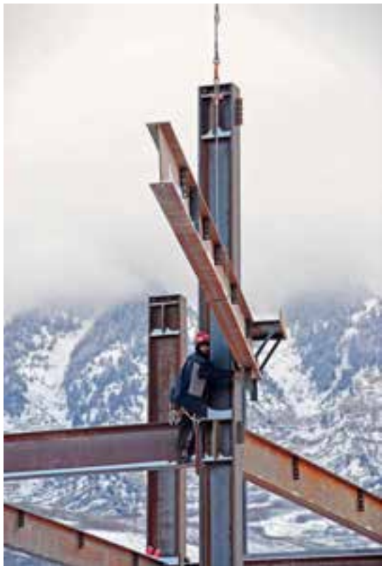
اجرای اسکلت فولادی در ارتفاع
