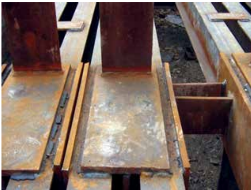
شکل ۴-۲۳- جزئیات ورق اتصال در قاب‌های خمشی
