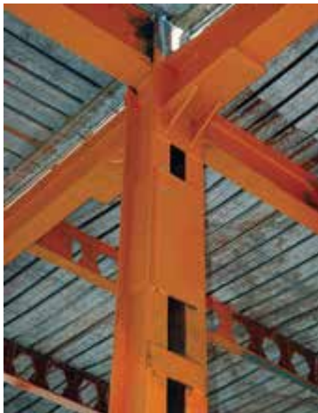
شکل ۴-۲۱- اتصال تیر به ستون دابل پا باز
