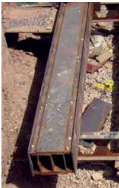
شکل ۴-۱۸- مقطع مرکب سه‌تایی با ورق تقویتی
