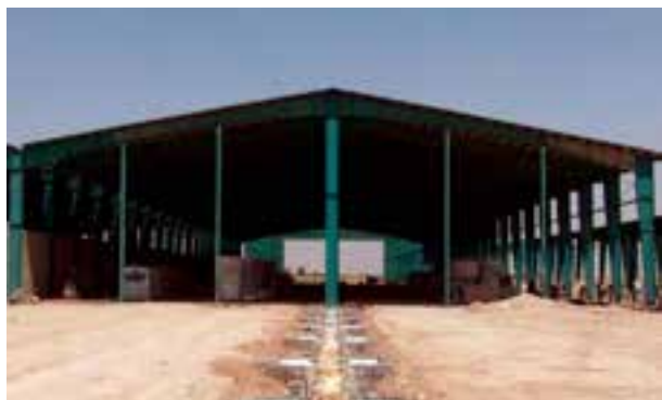
شکل ۲-۵- سازه‌های قابی صنعتی
