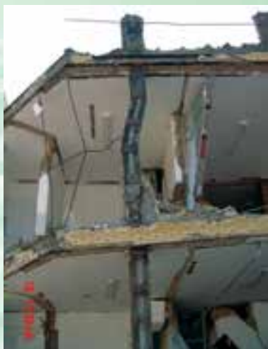
نمونه هایی از کمانش کلی ستون
