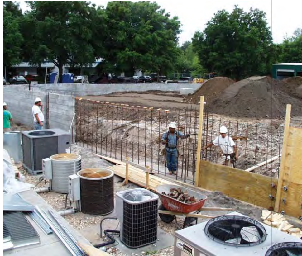
Pouring the Foundation
