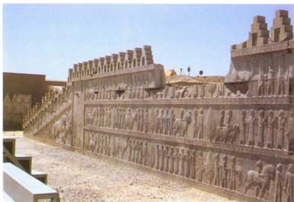
۸۲. جبهه جنوبی پلکان شرقی آبادانا که منقوش به بیست و سه گروه هدیه آور بوده است و گزندی ناهنجار دیده بود. (این عکس توسط مؤلف در ۱۹۷۰ م. گرفته شده است).
