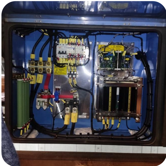
شکل ۲۷: مجموعه باتری شارژر (شکل راست) - برد GDU، IGBT ها، مقاومت های شارژ و دشارژ
