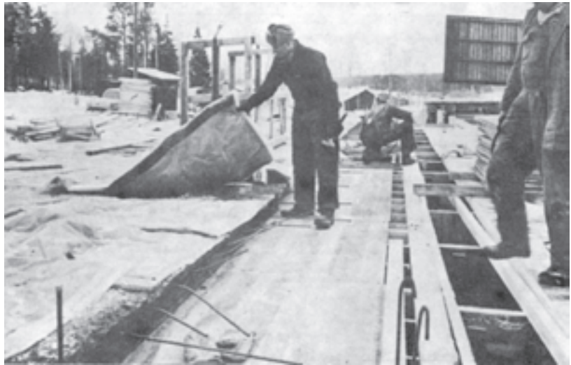
شکل ۶-۳۰- روکش‌های عایق ساخته شده با الیاف معدنی در ورقه‌های پلاستیک برای محافظت دال
