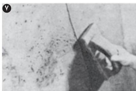
شکل ۶-۴۳- روش ترمیم سطح کرمو و لبه‌های شکسته شده سازه‌های بتنی
