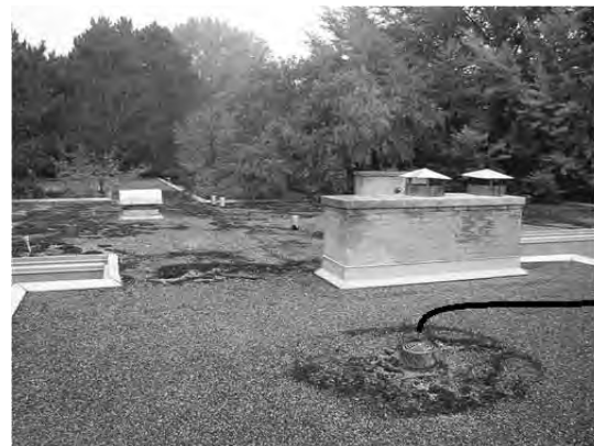
صرف نظر از شیب بام، در صورتی که امکان جمع شدن آب بر روی بام به منظور رسیدن به شبکه زهکشی فرعی وجود داشته باشد، ناپایداری انباشتگی آب می‌تواند رخ دهد.
