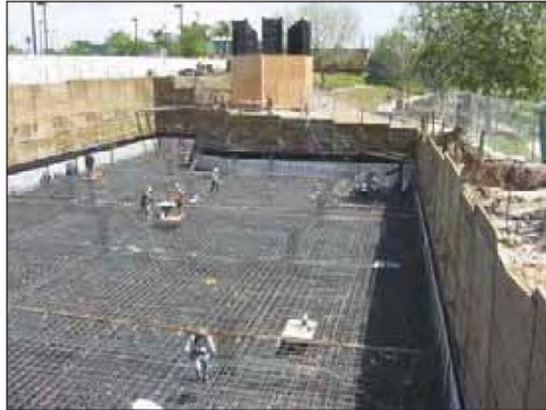
شکل ۱-۶۲ پی بتن مسلح یکپارچه (رادیه ژنرال)
