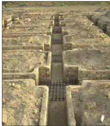
شکل ۴۸-۱ آرماتورگذاری پی تکی کلاف بندی شده
