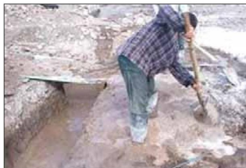
شکل ۱-۳۱ اجرای شفته آهک در فنداسیون
