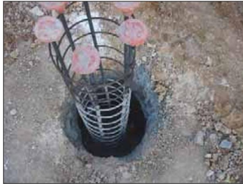
شکل ۱-۷۳ پی چاهی در حال اجرا
