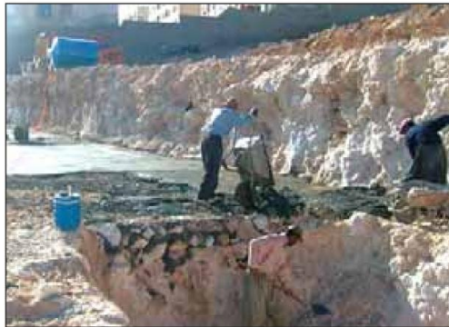
شکل ۸۷-۱ گودبرداری دستی (با بیل و کلنگ)
