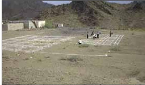
شکل ۸۳-۱ پیاده کردن نقشه روی زمین
