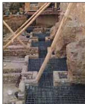
شکل ۹۰-۱ مهاربندی با شمع چوبی
