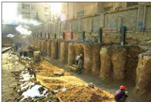
شکل ۸۸-۱ مهاربندی با پشت بند خاکی ستونی
