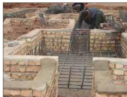
شکل ۱-۸۲ قالب بندی آجری در اطراف پی
