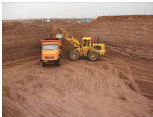
شکل ۸۵-۱ گودبرداری با لودر در زمین نامحدود
