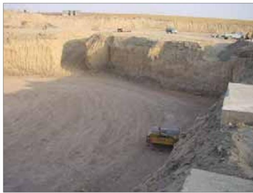
شکل ۸۴-۱ زمین گودبرداری شده
