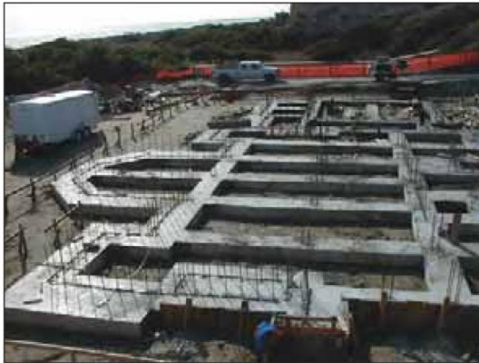
شکل ۱-۵۶ پی بتن مسلح نواری شبکه ای زیرستون
