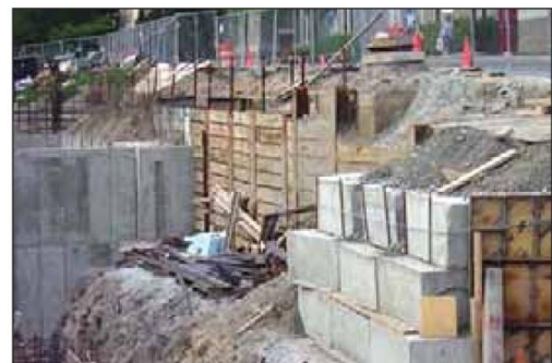
شکل ۹۱-۱ مهاربندی با دیوار مانع چوبی
