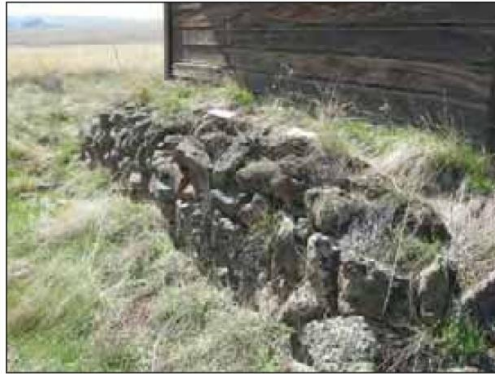
شکل ۱-۳۲ پی سنگی با سنگ لاشه
