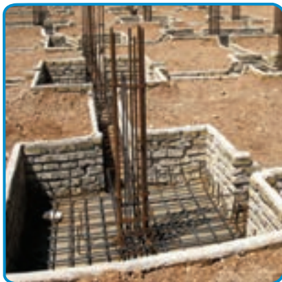
شکل ۴-۷- اجرای میلگردهای ریشه انتظار
