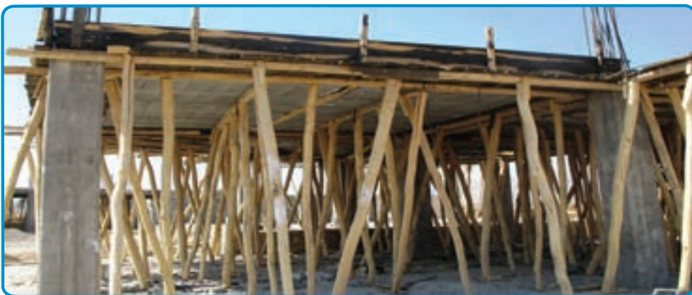
شکل ۳-۲۴- استفاده از شمع‌های چوبی جهت نگهداری قالب‌ها
