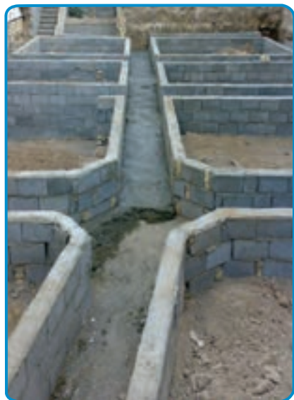
شکل ۶-۷- آماده سازی کف پی
