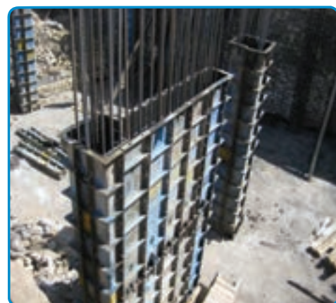
شکل ۳-۳۵- قالب فلزی برای اجرای دیوار بتنی
