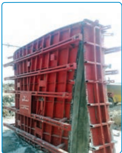
شکل ۳-۴۲- قالب برداری
