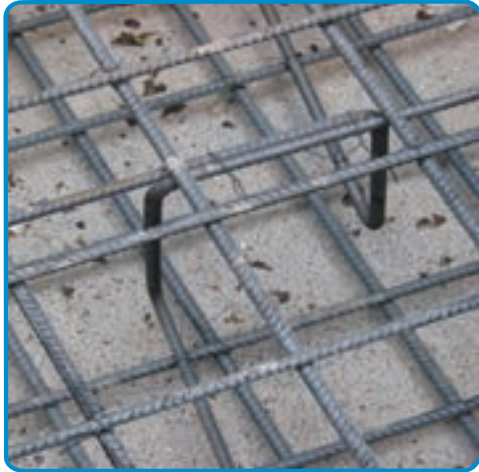
شکل ۳-۵۳ - استفاده از خرک در میلگرد گذاری پی
