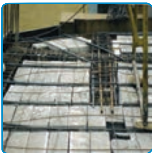
شکل ۳۲-۷-اجرای تیرهای فرعی کنسول
