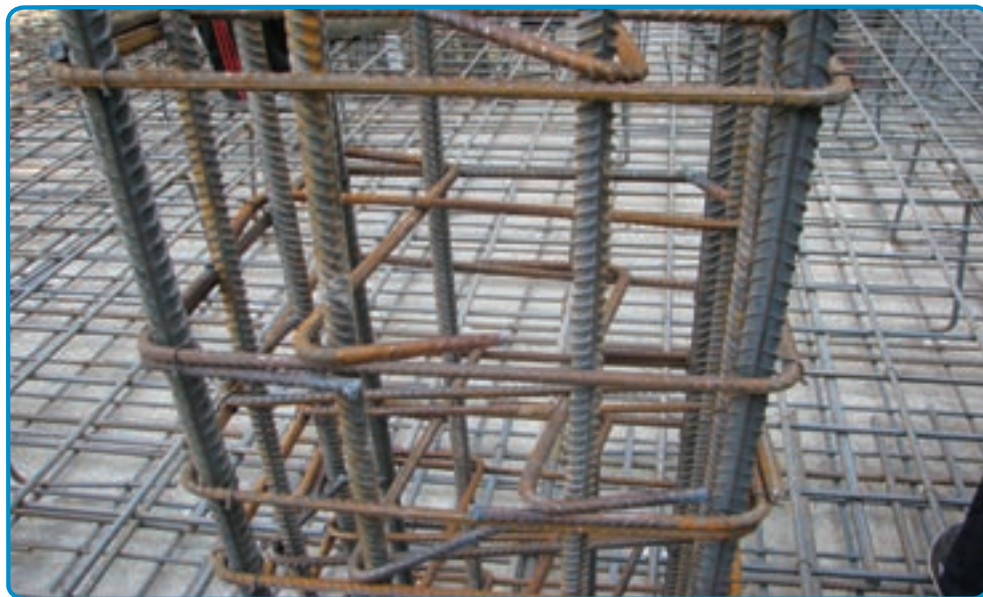
شکل ۵۰-۳- کاربرد سنجاک در میلگرد گذاری ستون
