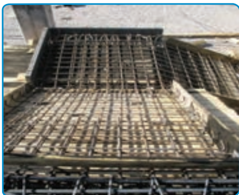
شکل ۳۷-۷- اجرای میلگردهای دال پله
