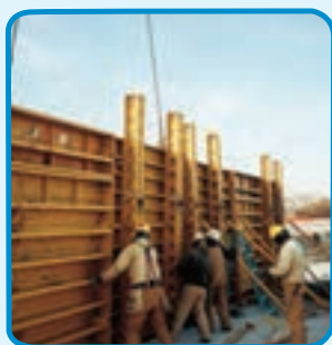
شکل ۳-۳۶- قالب فایبر گلاس برای اجرای دیوار بتنی
