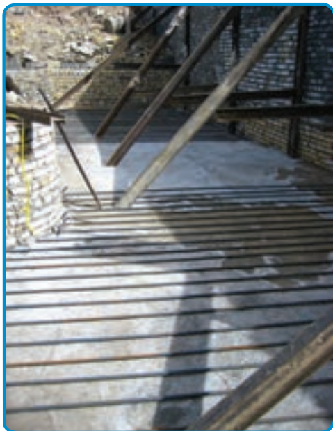
شکل ۳-۴۶- میلگرد طولی کف پی
