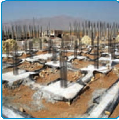
شکل ۱۷-۷- اجرای خاموت و سنجاقک
