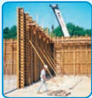
شکل ۱۹-۳- اجرای دیوار بتنی فایبر گلاس برای
