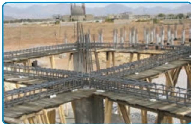
شکل ۷-۲۷- رعایت فاصله پوشش بتنی در کف
