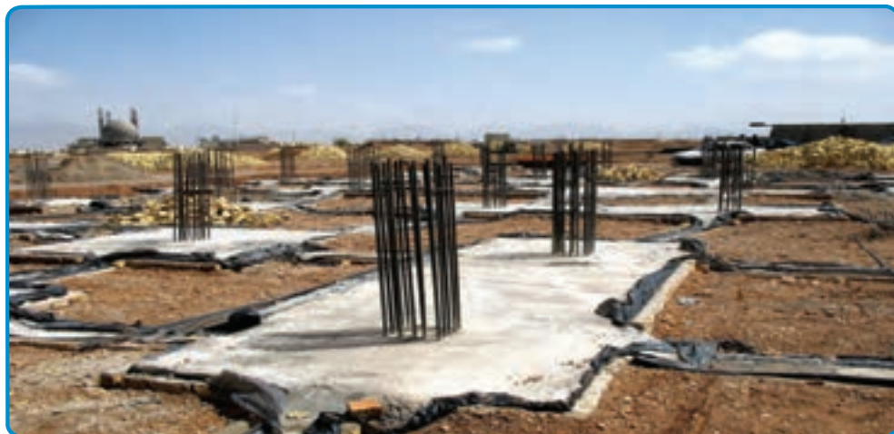
شکل ۱۰-۳- استفاده از پلاستیک در پی
