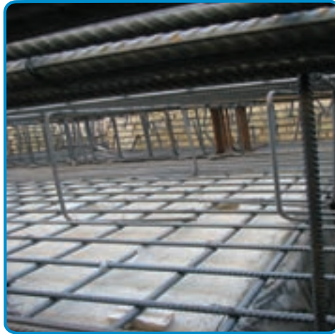
شکل ۳-۵۳ - استفاده از خرک در میلگرد گذاری پی
