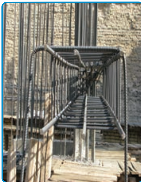
شکل ۳-۴۵- میلگرد طولی در تیر
