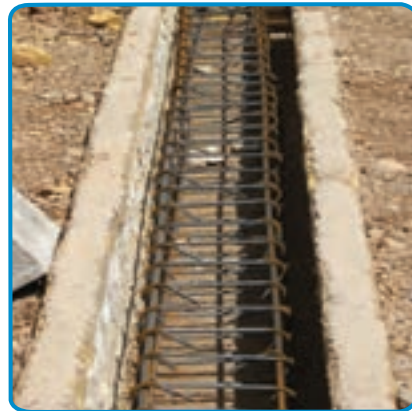
شکل ۵-۷- اجرای میلگرد شناژها
