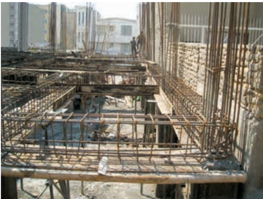
تصویر ۱۲ - نحوه‌ی قرارگیری آرماتورهای کلاف‌های بتنی
