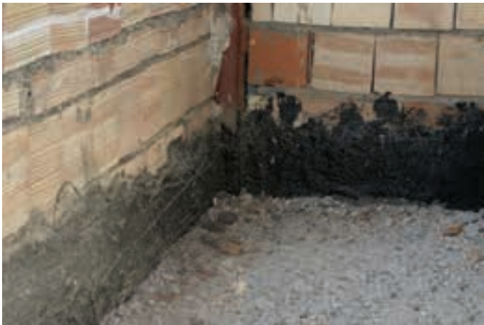
تصویر ۱۶ - عایق‌کاری کف سرویس بهداشتی
