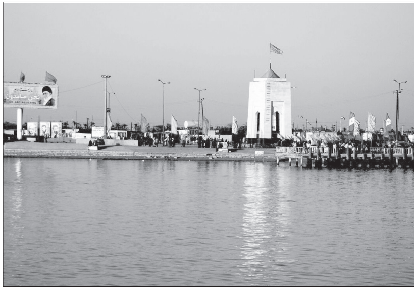
یادمان شهدای عملیات والفجر ۸، اروندکنار، استان خوزستان.
