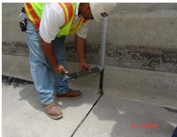
شکل ۴: پر کردن شکاف با ماده ی قابل ارتجاع
