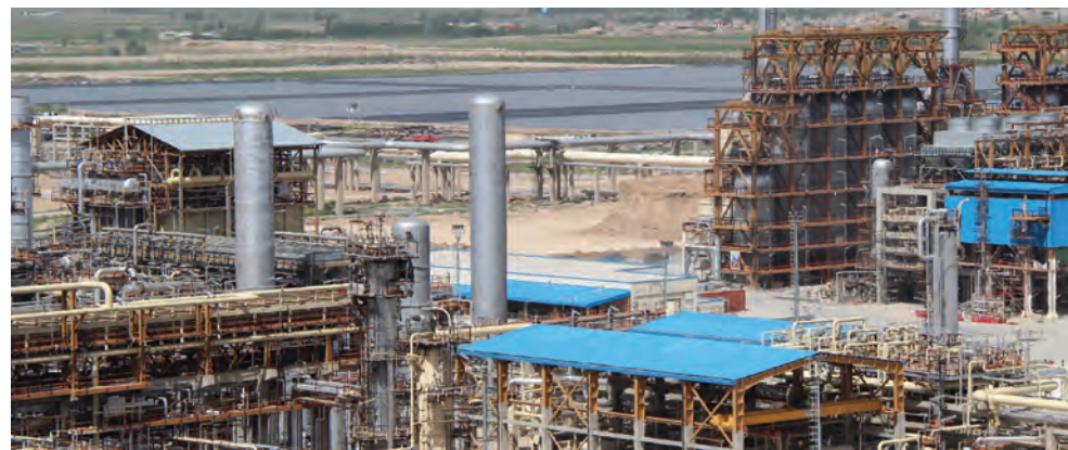
شکل ۴- نمایی از یک برج تقطیر برای جداسازی اجزای هوا در پتروشیمی ماهشهر
