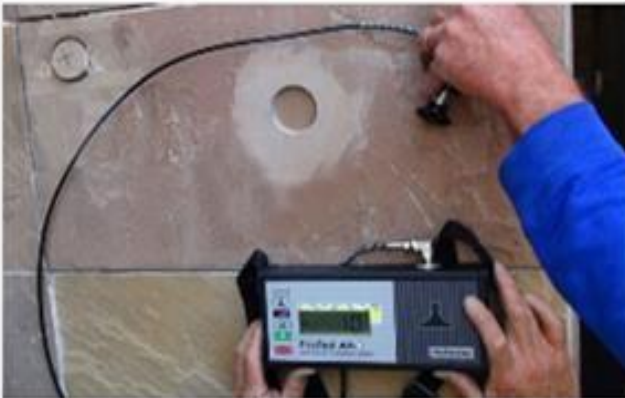
تست PULL OFF بتن
