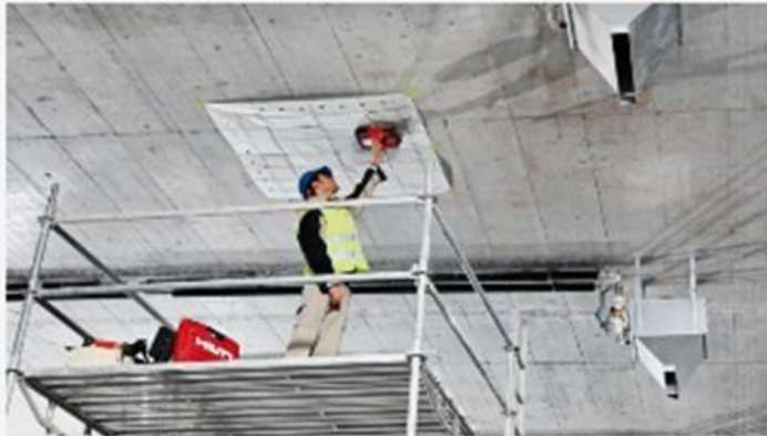
اسکن میلگرد (آرماتور) در بتن
