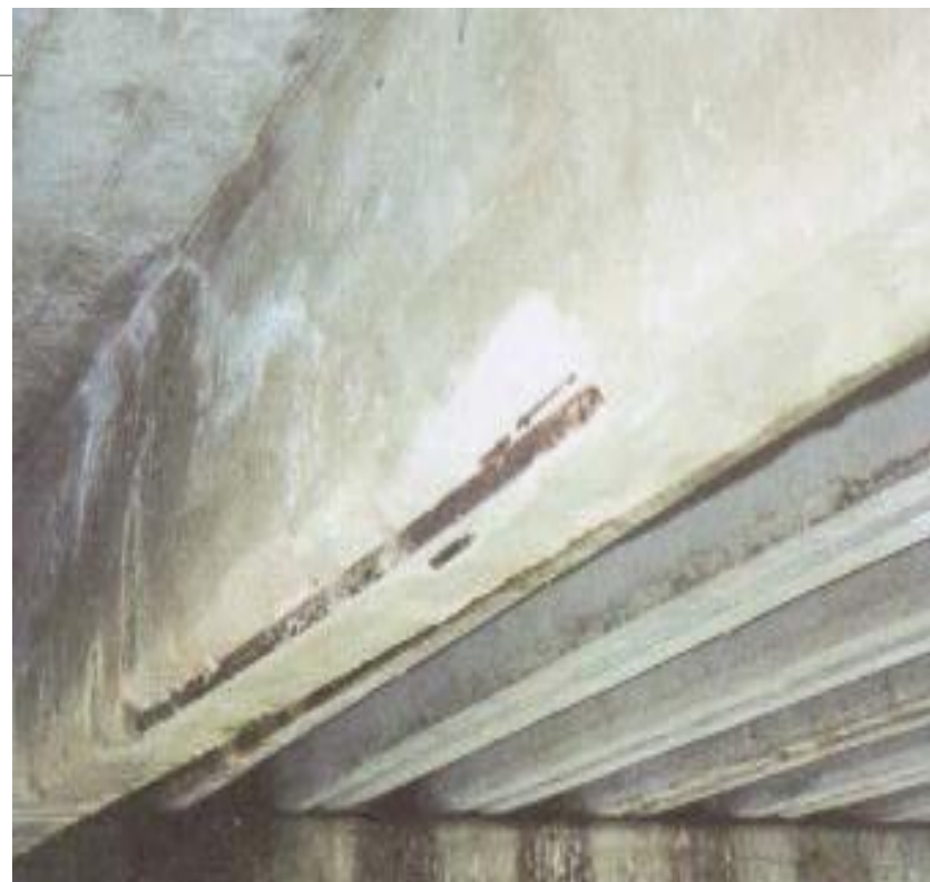
پوسته شدگی و نمایان شدن آرماتور نشانگر خرابی با اهمیت متوسط است. البته بتن دارای ترک نیز میباشد.
