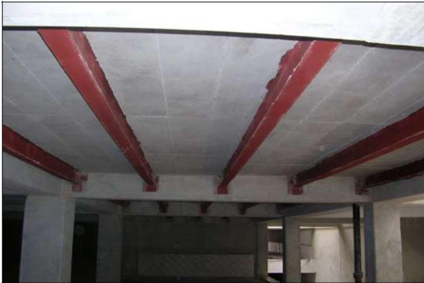
شکل ۲-۳-۵- اضافه کردن تیرک فولادی
