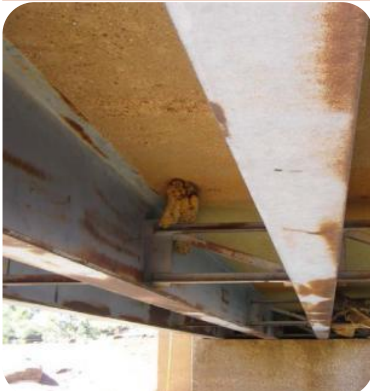
خوردگی جزئی در اتصالات، خوردگی سطحی موضعی
