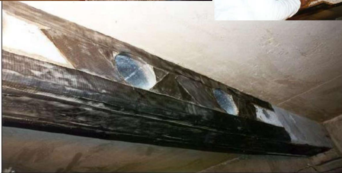
شکل ۲-۴-۱۵- تقویت موضعی سوارخ‌ها در تیر FRP
