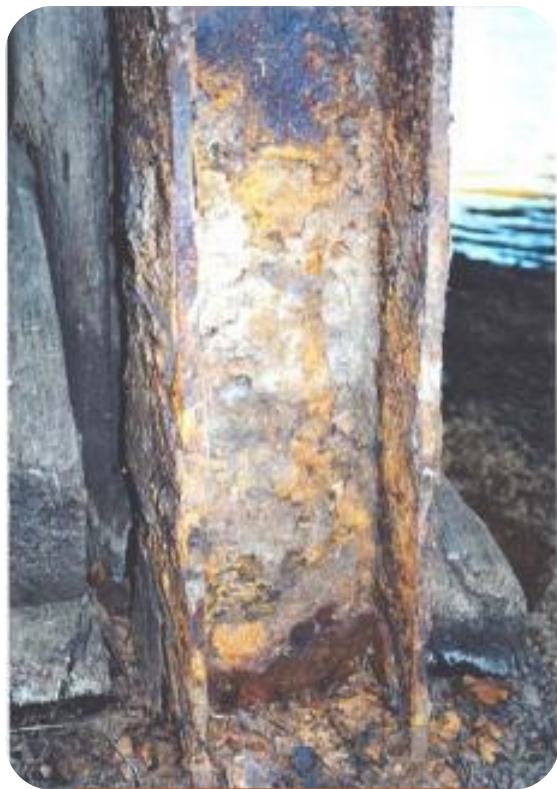
مقطع فولادی به شدت دچار خوردگی شده است.
