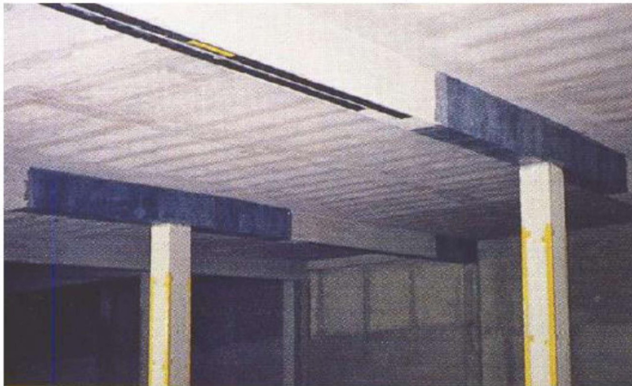
شکل ۲-۴-۸- کاربرد مصالح FRP در مقاوم سازی
