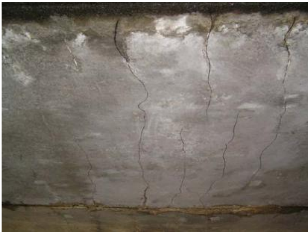
ترکهای مکرر با عرض بزرگتر از ۰.۳ میلیمتر وجود دارد.
