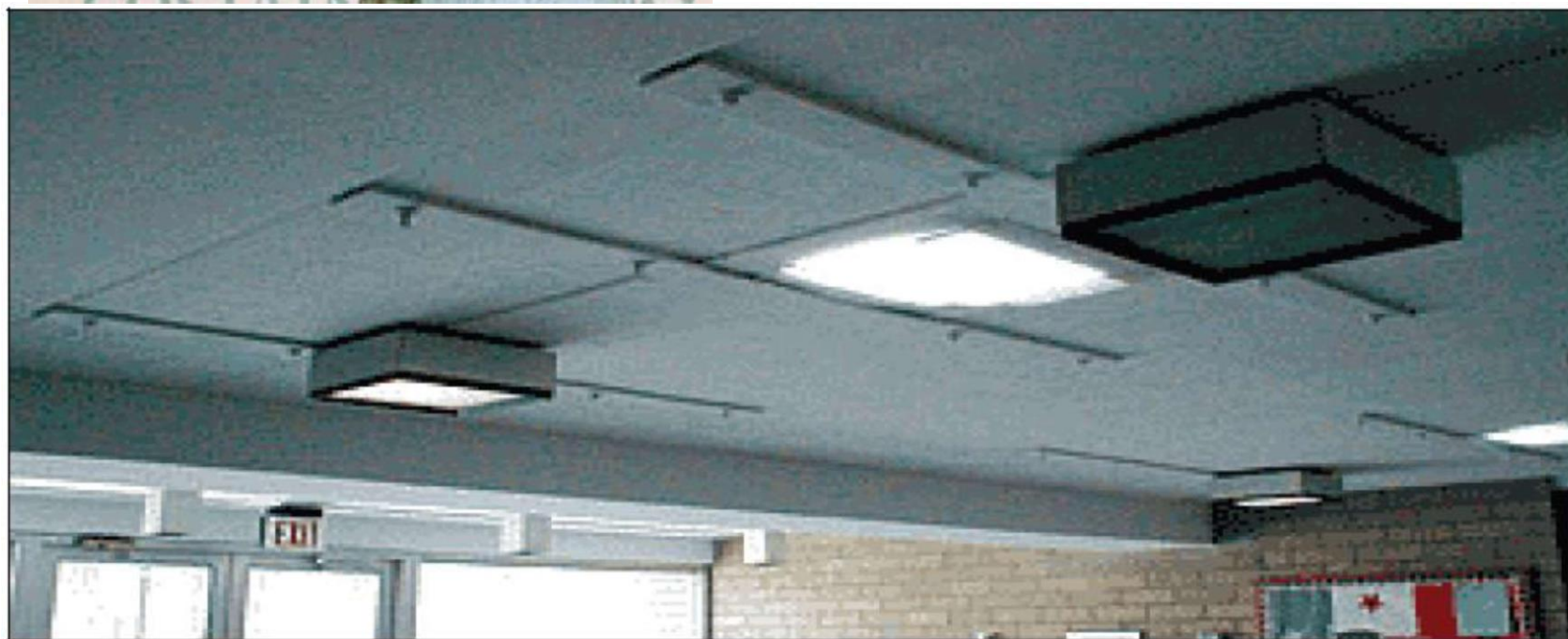
شکل ۲-۳-۷- تقویت دال‌ها با استفاده از ورق‌های فولادی
