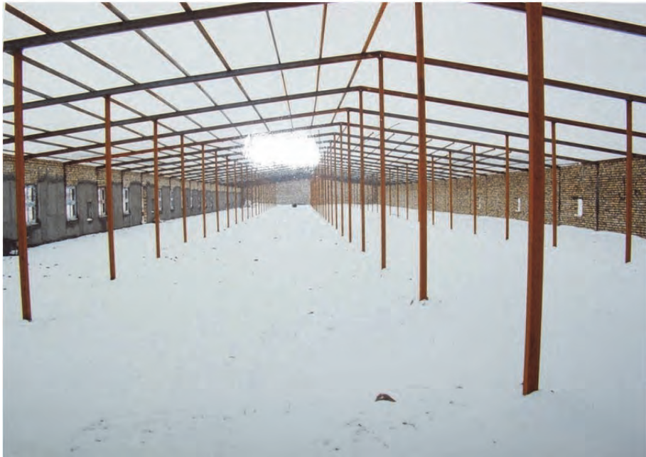
شکل ۳- اضافه شدن ستون‌ها در سالن در حال احداث به عرض ۲۲ متر
