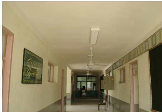
شکل ۹. عملکرد مناسب و بدون آسیب ساختمان مدرسه مقاوم سازی شده در زلزله ۵ مهرماه ۱۳۸۹ فارس (کازرون) ( بزرگای زلزله ۶ ریشتر در عمق ۲۰ کیلومتری از سطح زمین )
