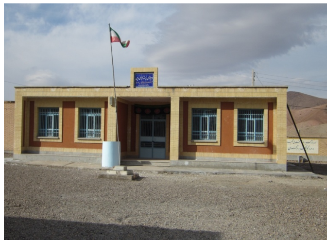
شکل ۱۰. عملکرد مناسب و بدون آسیب ساختمان مدرسه مقاوم سازی شده در زلزله سال ۱۳۹۰ خراسان جنوبی
