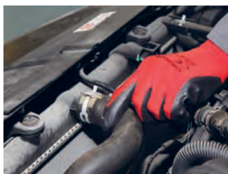
۵ اتصالات شیلنگ‌های سیستم خنک‌کاری
