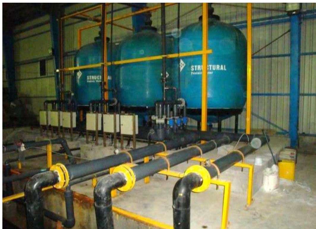
شکل ۵۳- آب شیرین کن سوزا - فیلترهای شنی (واحد نیمه اتوماتیک)
