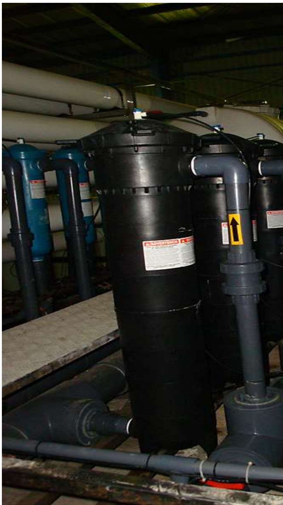
شکل ۵-۵۶- آب شیرین کن سوزا - فیلتر کارتریج
