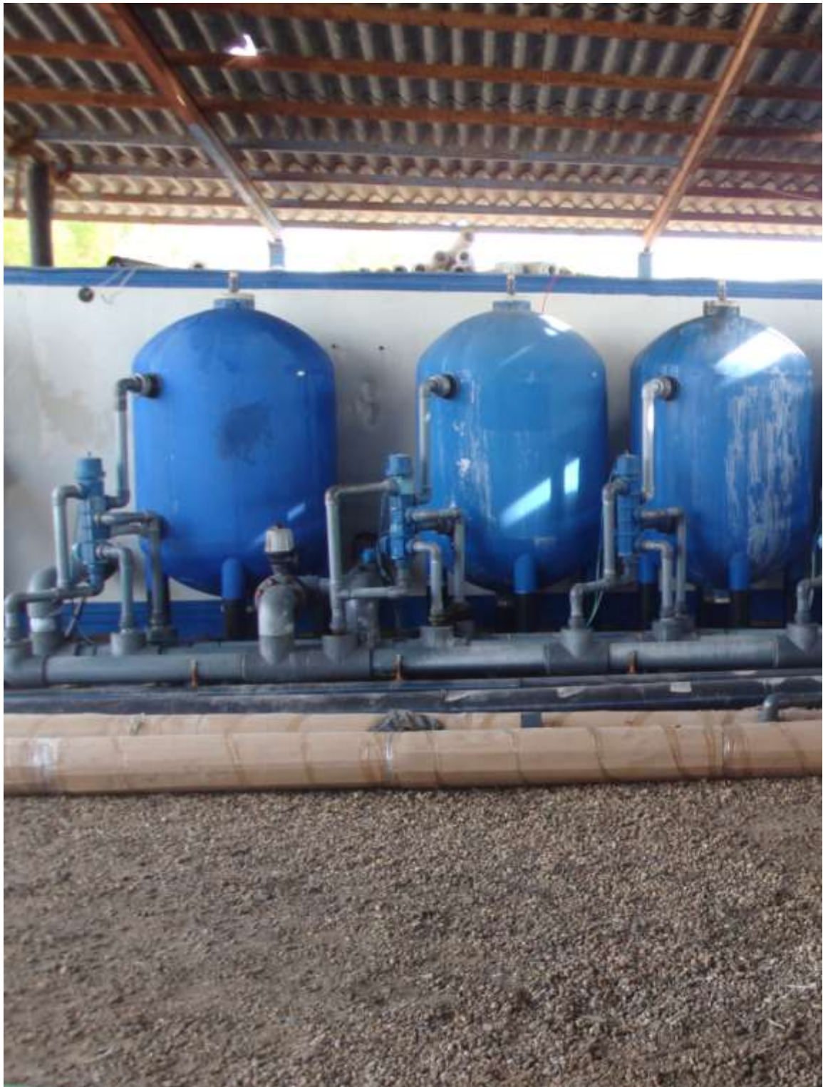
شکل ۵-۱۱- آب شیرین کن بندر لنگه - واحد شماره ۱- فیلترهای شنی
