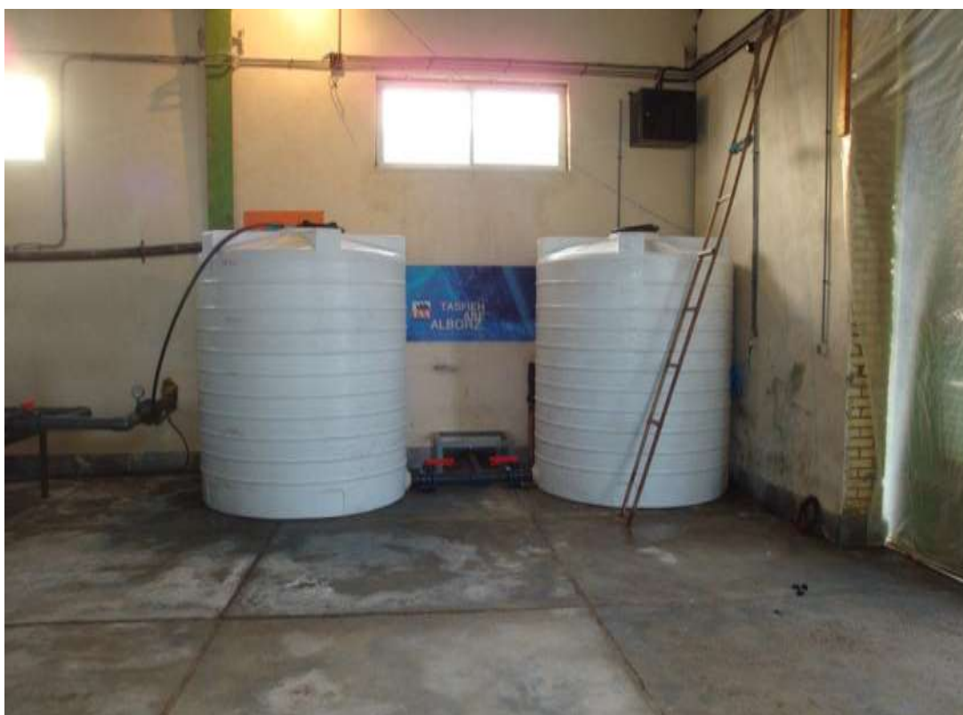
شکل ۵-۴۷- آب شیرین کن جزیره هنگام - مخازن ذخیره موقت آب تصفیه شده
