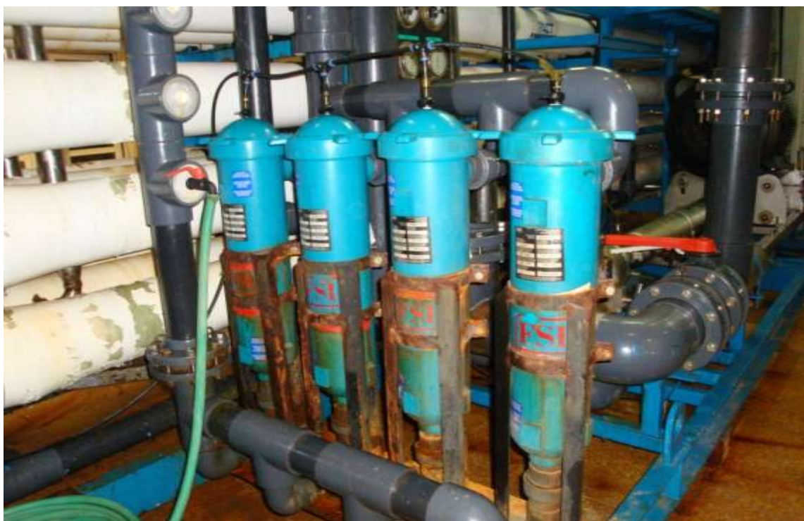
شکل ۵-۲۸- آب شیرین کن جزیره هرمز - زیر واحدهای ۸۰۰ متر مکعبی - فیلتر نهایی
