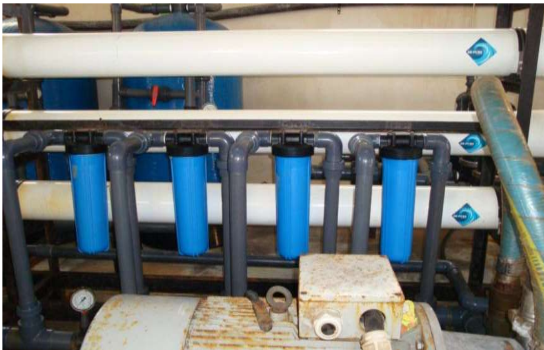
شکل ۵-۴۴- آب شیرین کن جزیره هنگام - فیلترهای نهایی پیش تصفیه (مارک ABSOLUTE)
