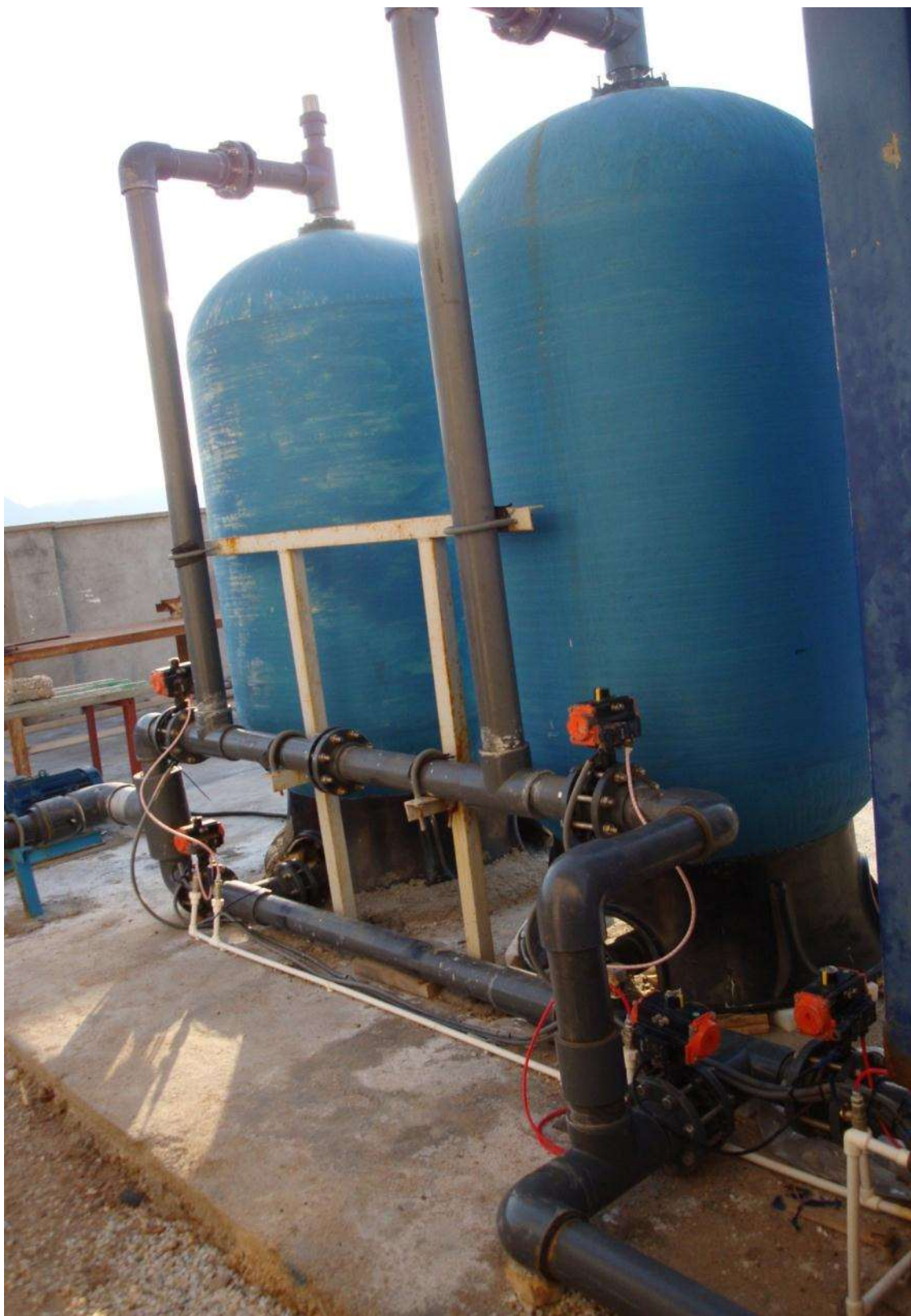
شکل ۵-۲۹- آب شیرین کن جزیره هرمز - زیر واحدهای ۵۰۰ متر مکعبی - فیلتر شنی
