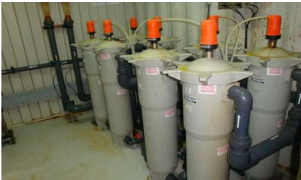
شکل ۵-۳۳- آب شیرین کن جزیره لارک - فیلترهای کارتریج
