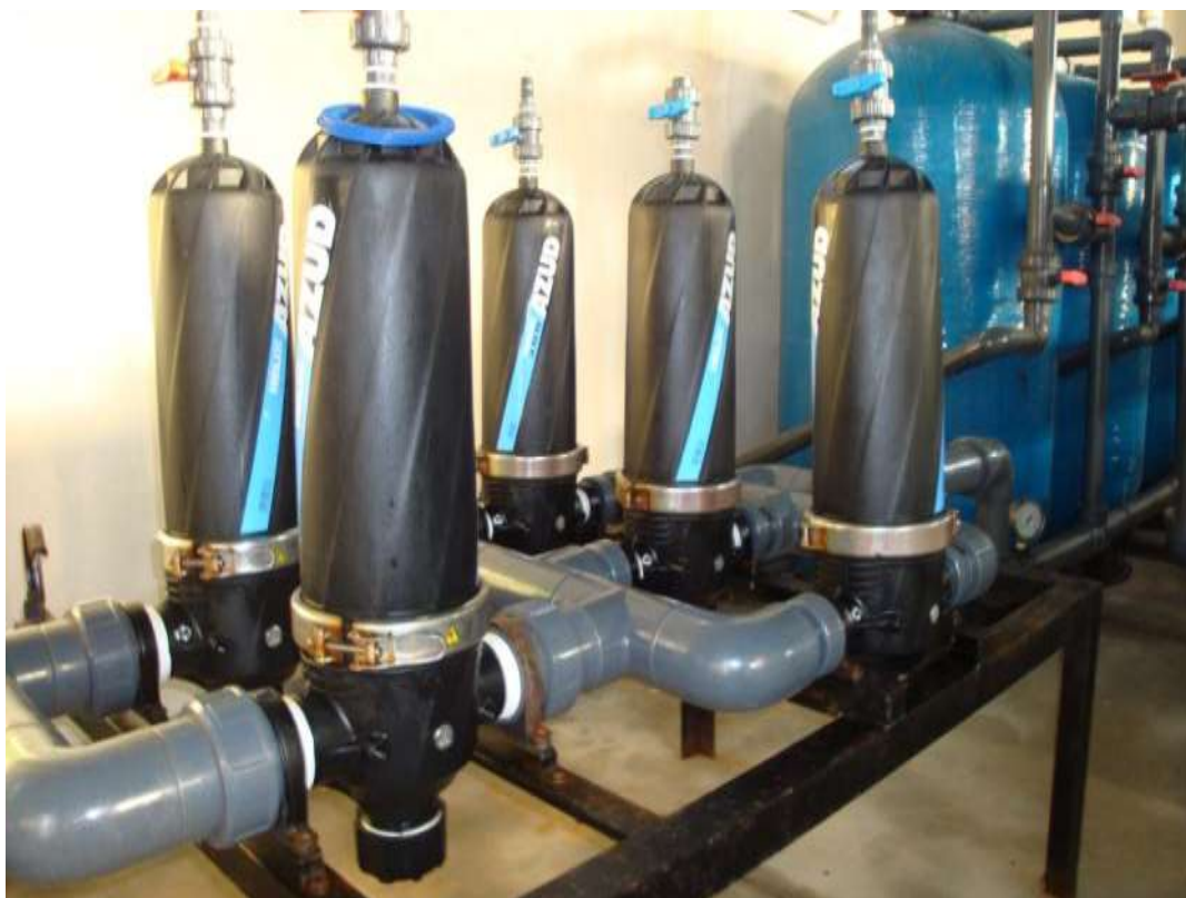
شکل ۵-۴۰- آب شیرین کن جزیره هنگام - فیلترهای اولیه پیش تصفیه (مارک AZUD)
