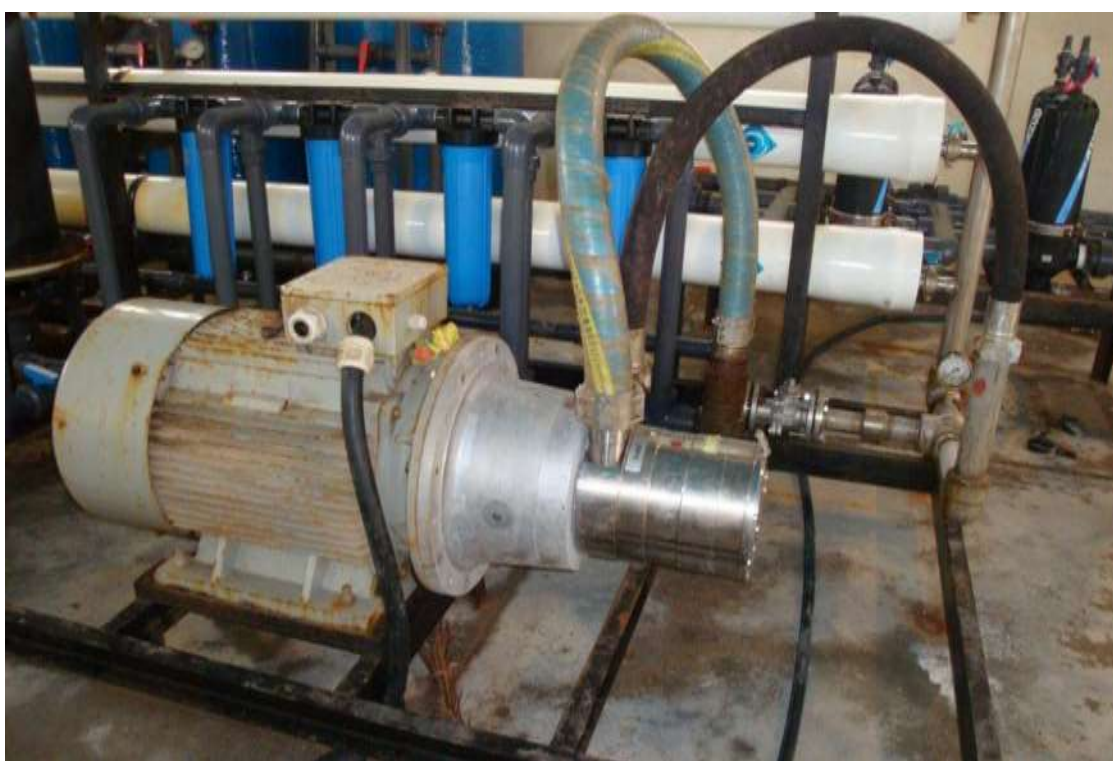
شکل ۵-۴۵- آب شیرین کن جزیره هنگام - پمپ فشار قوی
