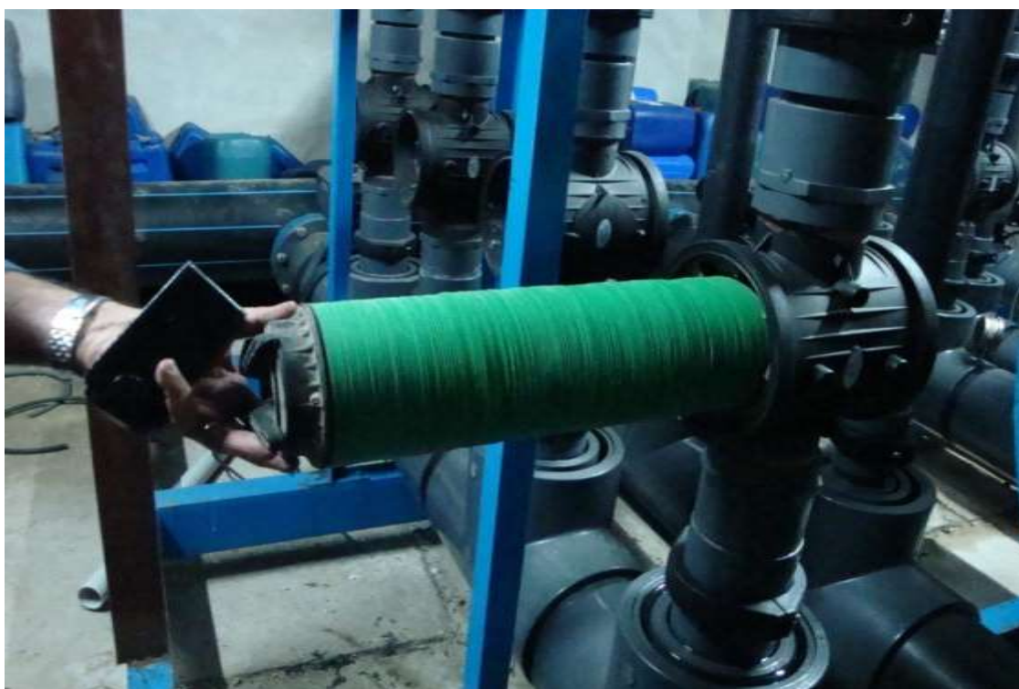
شکل ۵-۶۴- آب شیرین کن درگهان - فیلترهای دیسکی
