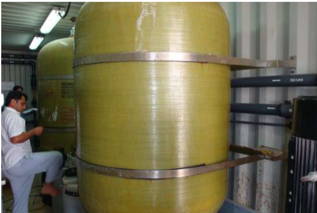
شکل ۵-۳۱- آب شیرین کن جزیره لارک - فیلترهای شنی
