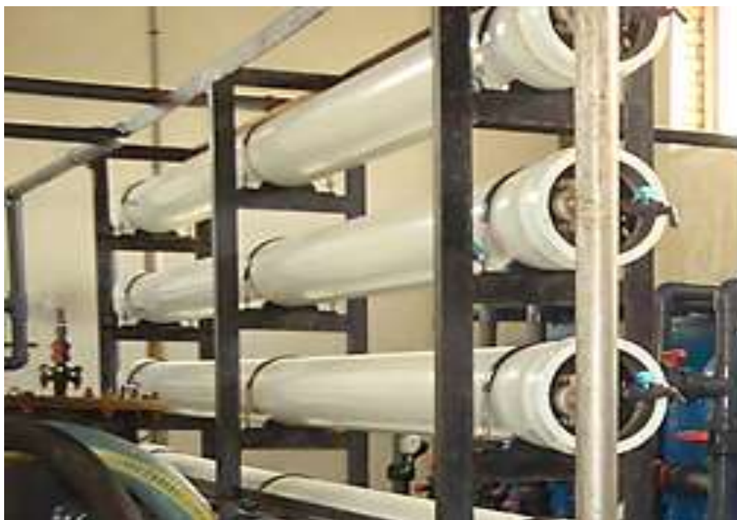
شکل ۵-۴۶- آب شیرین کن جزیره هنگام - وصل های RO
