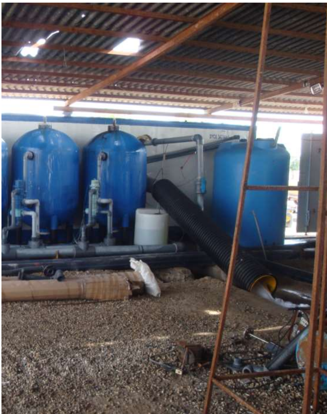
شکل ۵-۱۲- آب شیرین کن بندر لنگه - واحد شماره ۱- فیلترهای کربن و مخزن آنتی اسکالانت
