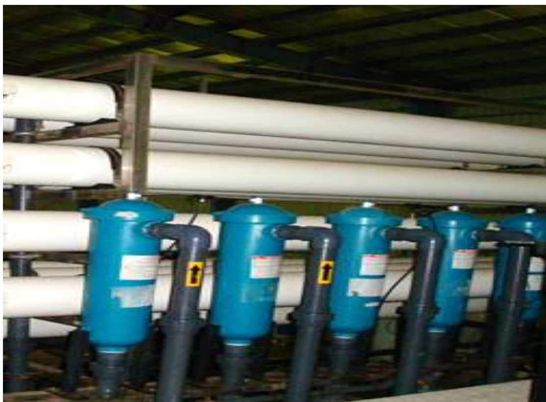
شکل ۵-۵۸- آب شیرین کن سوزا - BAC Filter های نهایی (واحد تمام اتوماتیک)
