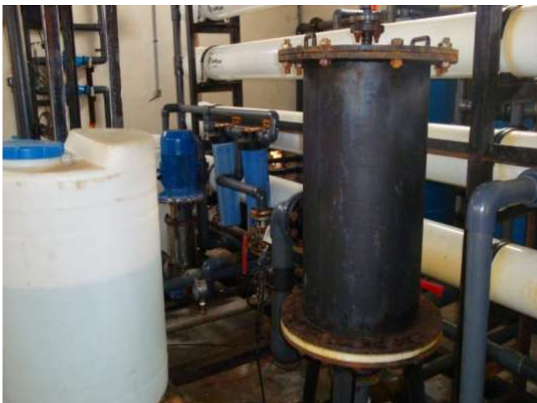
شکل ۵-۴۳- آب شیرین کن جزیره هنگام - فیلتر کارتریج
