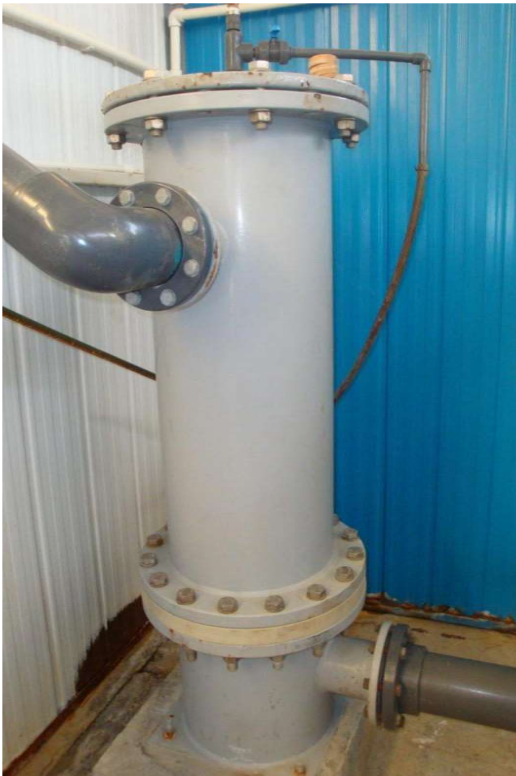
شکل ۵-۶- آب شیرین کن شهر فین - فیلتر کارتریج
