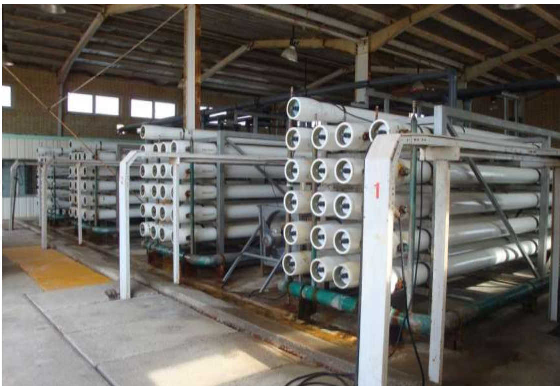
شکل ۵-۱۹- آب شیرین کن بندر لنگه - واحد شماره ۲ - وصل های RO
