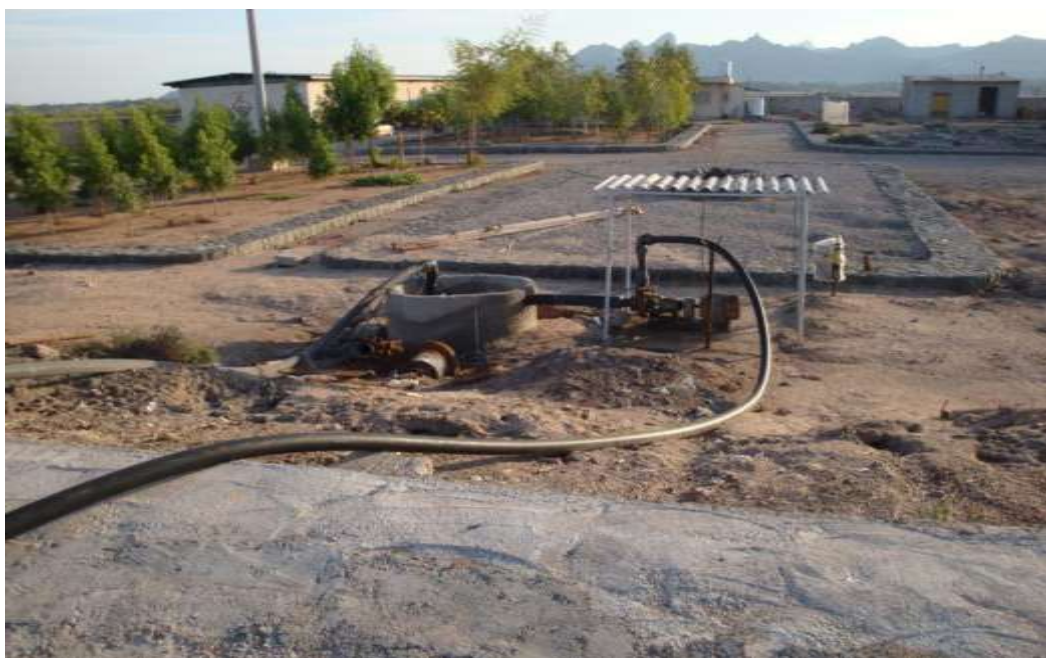
شکل ۵-۲۳- آب شیرین کن جزیره هرمز - مخزن ذخیره (ته نشینی) آب خام
