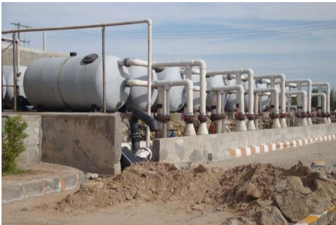
شکل ۵-۱۸- آب شیرین کن بندر لنگه - واحد شماره ۲ - فیلترهای شنی
