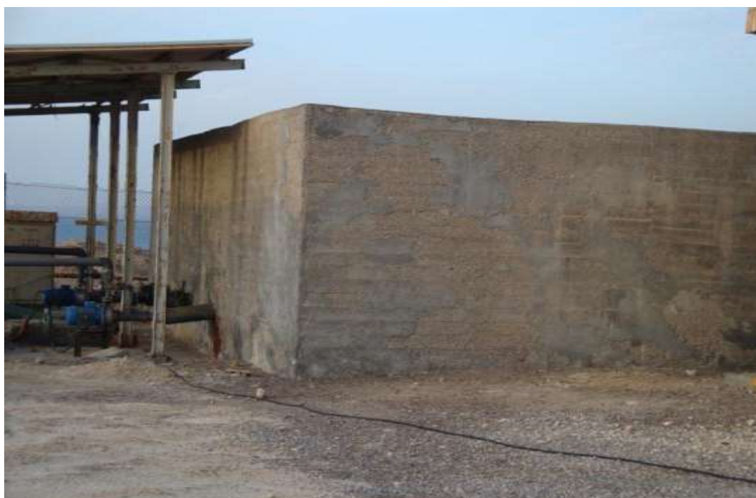
شکل ۵-۳۹- آب شیرین کن جزیره هنگام - مخزن ذخیره (ته نشینی) آب خام
