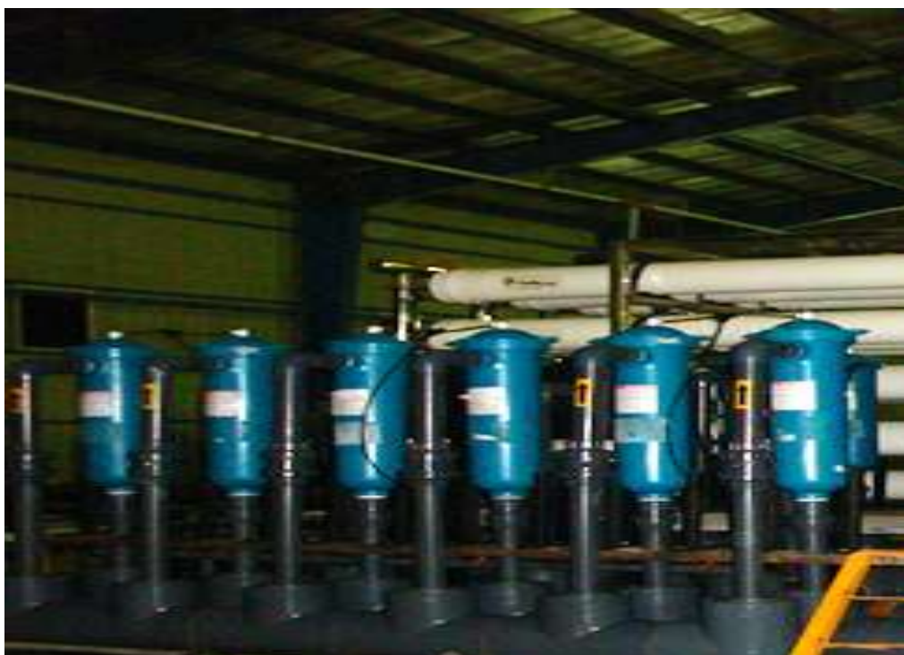
شکل ۵-۵۵- آب شیرین کن سوزا - BAC Filters
