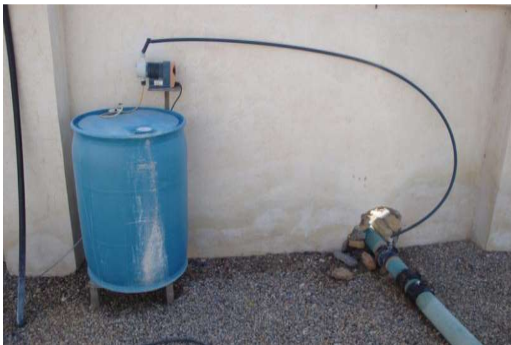
شکل ۵-۳۵- آب شیرین کن جزیره لارک - تاسیسات تزریق کلر
