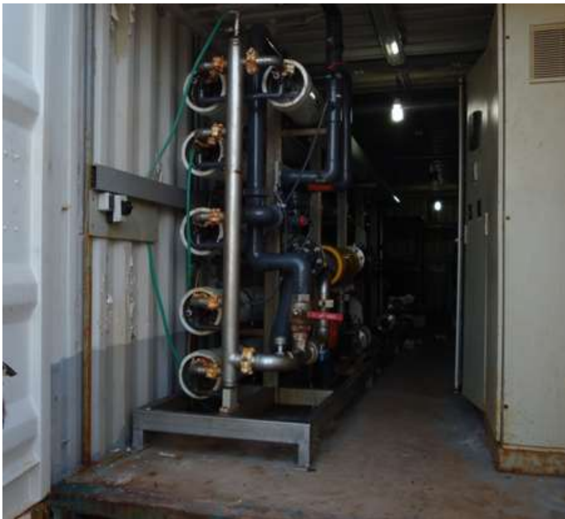
شکل ۵-۳۰- آب شیرین کن جزیره هرمز - زیر واحدهای ۵۰۰ متر مکعبی - وصل های RO
