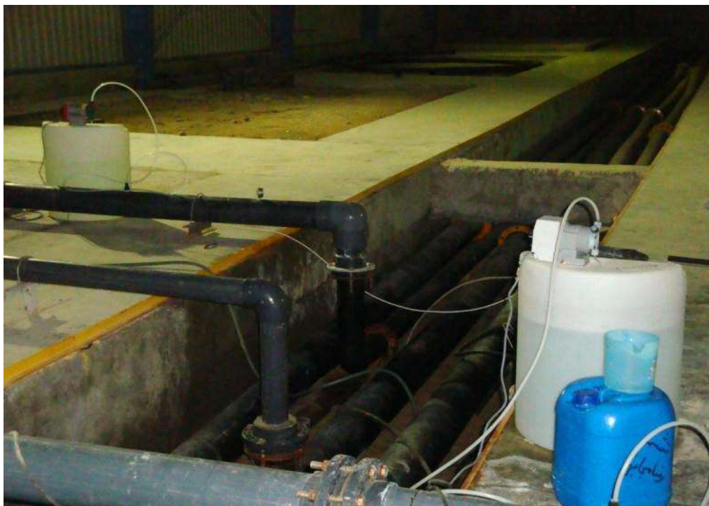
شکل ۵-۵۴- آب شیرین کن سوزا - مخزن آنتی اسکالانت، اسید و SMBS
