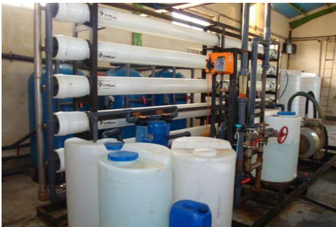
شکل ۵-۴۲- آب شیرین کن جزیره هنگام - مخازن آنتی اسکالانت
