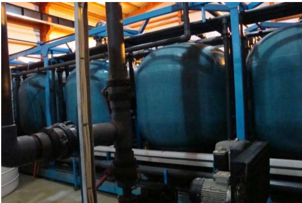
شکل ۵-۶۱- آب شیرین کن درگهان - فیلترهای شنی
