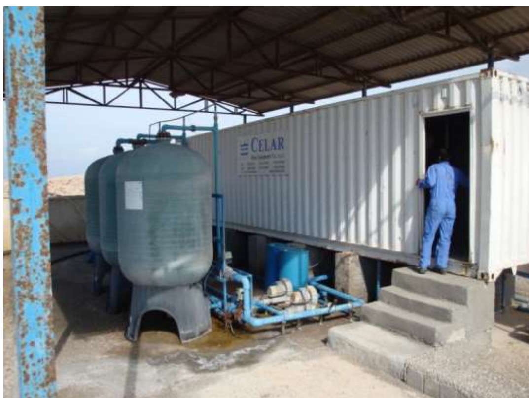
شکل ۵-۳۶- آب شیرین کن جزیره لارک - تاسیسات آب شیرین کن قدیمی - فیلترهای شنی
