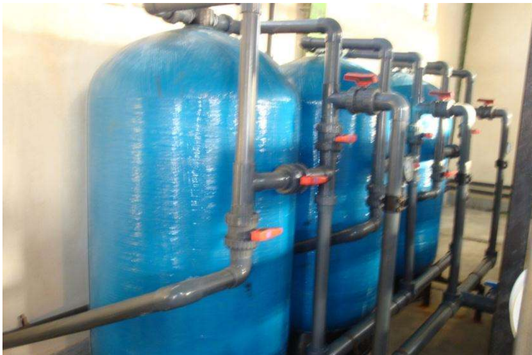
شکل ۵-۴۱- آب شیرین کن جزیره هنگام - فیلترهای شنی
