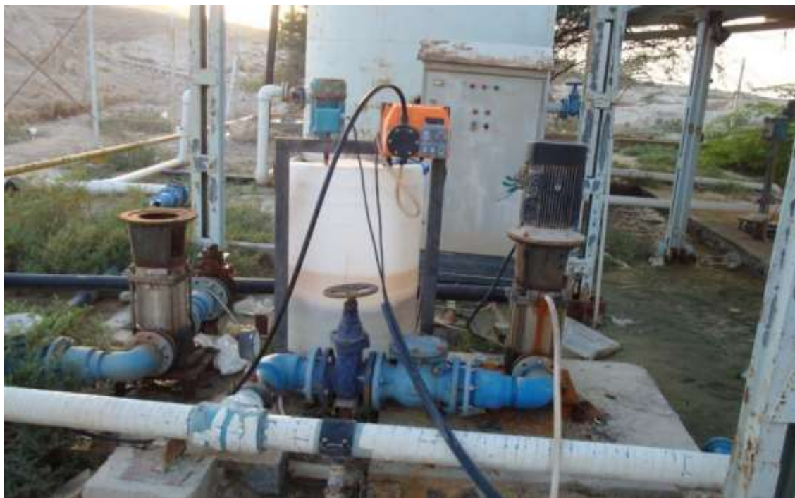
شکل ۵-۴۸- آب شیرین کن جزیره هنگام - تاسیسات تزریق کلر
