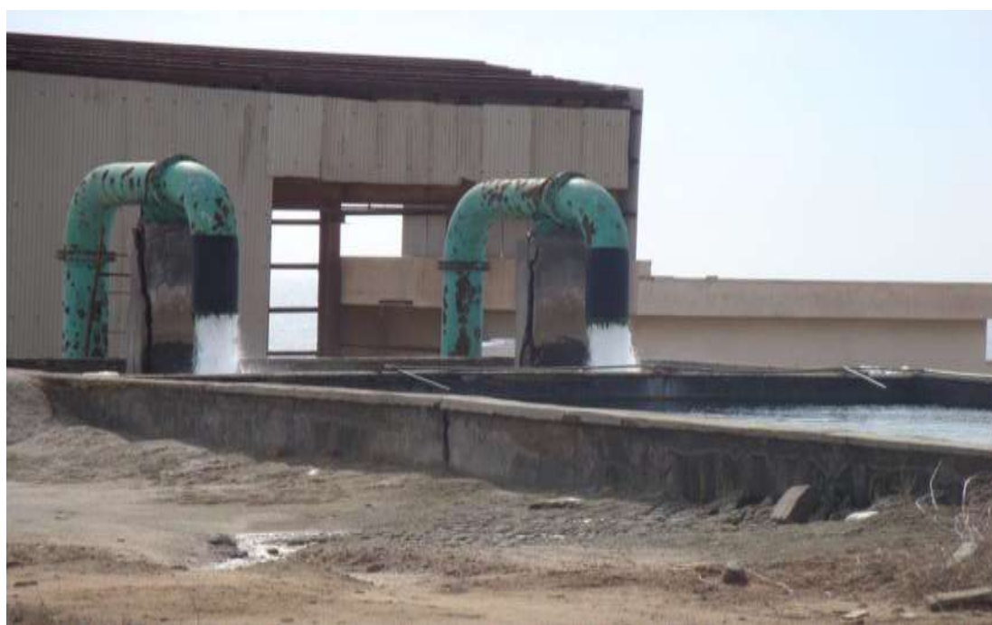
شکل ۵-۱۵- آب شیرین کن بندر لنگه - واحد شماره ۲- پمپ های مکش آب خام از آبگیر
