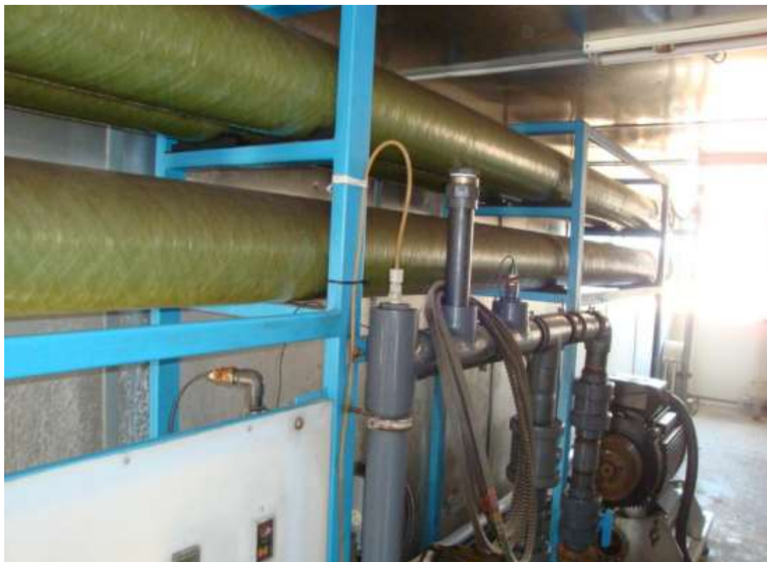
شکل ۵-۳۷- آب شیرین کن جزیره لارک - تاسیسات آب شیرین کن قدیمی - وصل های RO
